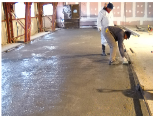
MASILLA PUENTE DE ADHERENCIA APLICADA
