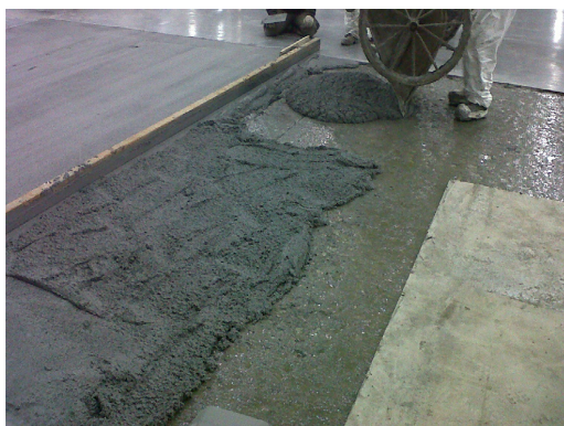
COLADO DE MORTERO CON IMPRIDAMP® FRESCO
