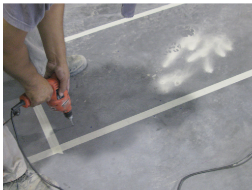
PERFORACIÓN DE AGUJEROS PARA GENERAR NODOS
