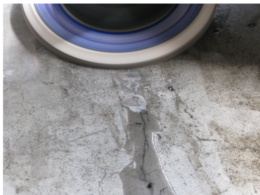
ELIMINACIÓN DEL EXCEDENTE CON LIJA - DISCO FLEXIBLE
