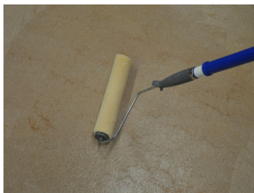
APLICACIÓN DE IMPRIDAMP MB® CON RODILLO
