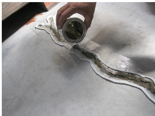
COLADO DIRECTO DE SELLAGRIET® EN UNA GRIETA
