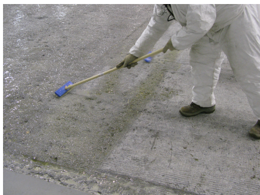
APLICACIÓN DE IMPRIDAMP® CON CEPILLO
