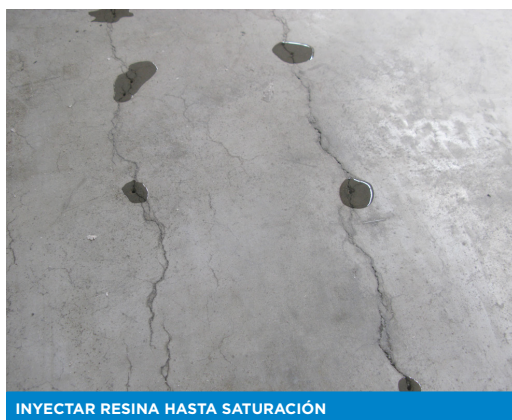
INYECTAR RESINA HASTA SATURACIÓN
