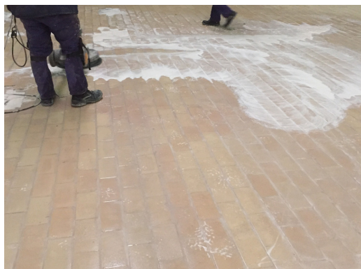
LIMPIEZA DEL EXCEDENTE CON FREGADORA Y PAD
