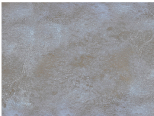
CUBRIR A SATURACIÓN EL HORMIGÓN
