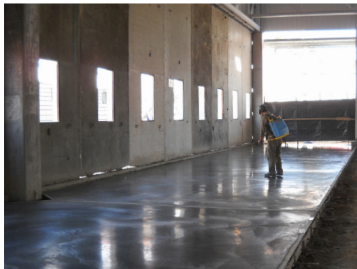
PULVERIZADO DE CURADOR MCG®
