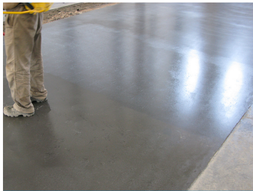
CURADOR MCG® EXTENDIDO CON RODILLO
