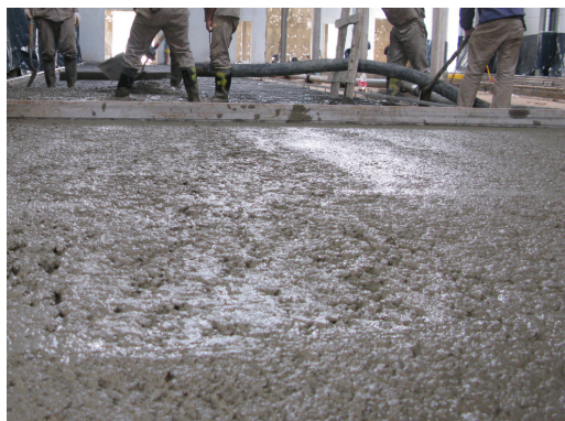
COLADO Y ENRASADO DEL HORMIGÓN
