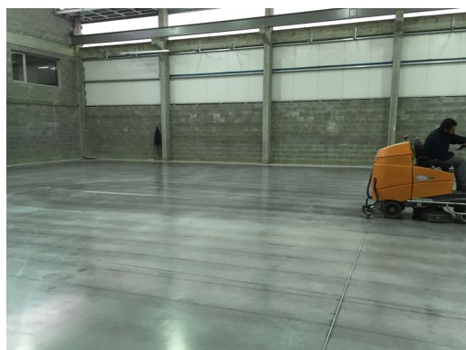
LAVADO DE LA SUPERFICIE
