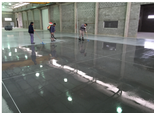
EXTENDIDO DE FERROSIL LITIO® CON MOPA PLANA
