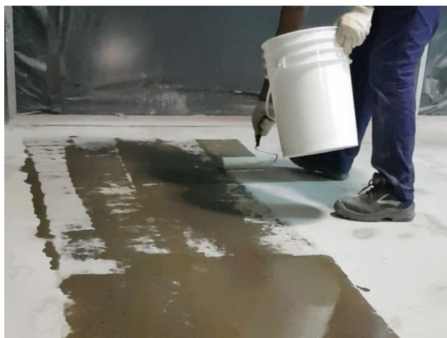
APLICACIÓN RAM C97® CON RODILLO
