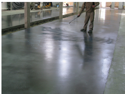
APLICACIÓN DE CURADOR MCG® O FERROCURE®
