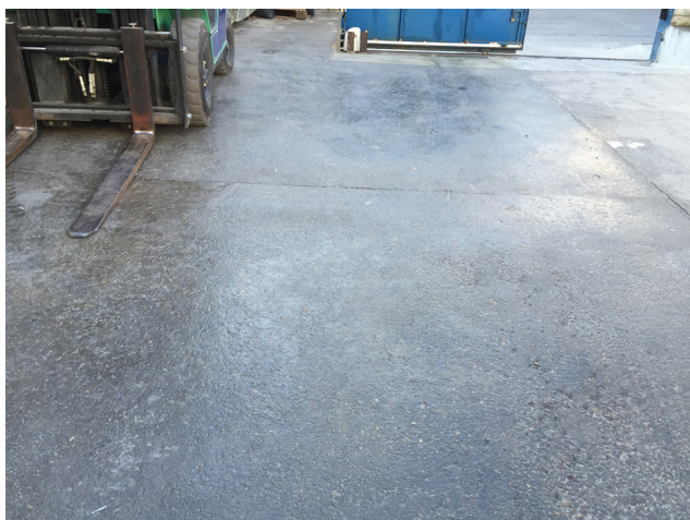
HORMIGÓN MUY POROSO CONSOLIDADO CON RAM C97®
