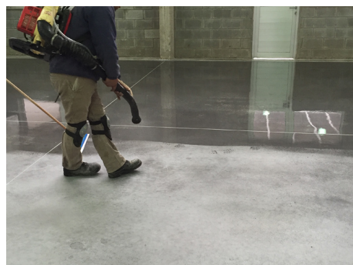
PULVERIZADO/ROCIADO DE FERROSIL LITIO®
