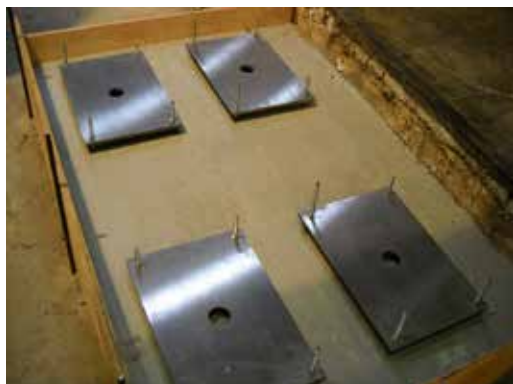
AJUSTE Y NIVELACIÓN DE LAS PLACAS
