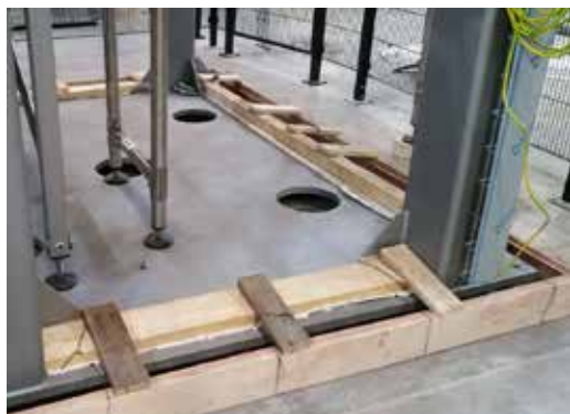
DETALLE DE ENCOFRADO RÍGIDO
