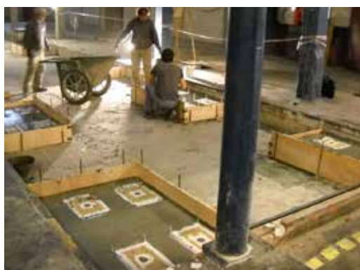
DETALLE DE GROUTING EN BASES DE PRECISIÓN
