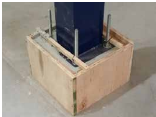
ASENTAMIENTO DEL MORTERO Y CURADO
