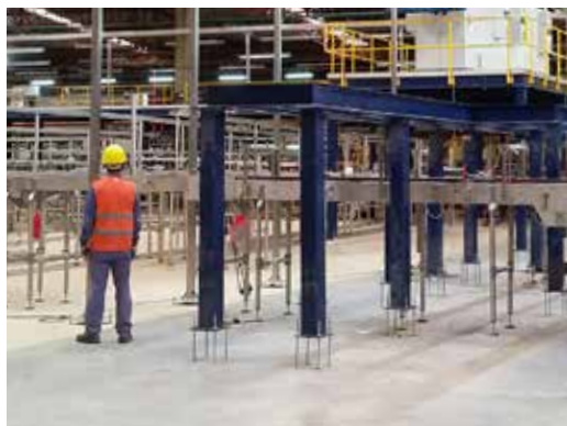
AJUSTE Y NIVELACIÓN DE COLUMNAS
