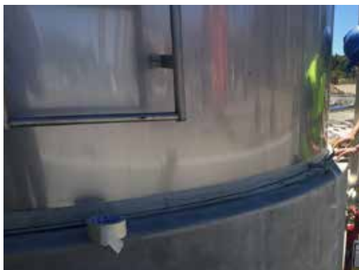
SELLADO PERIMETRAL PARA COLADO DE GROUTERLEX®
