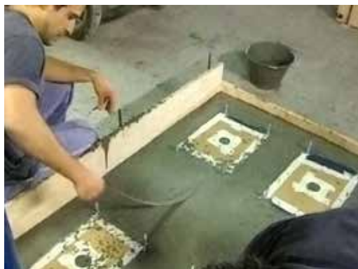
ACOMODAMIENTO DEL GROUT
