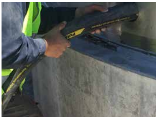
BOMBEO DE LECHADA FLUIDA
