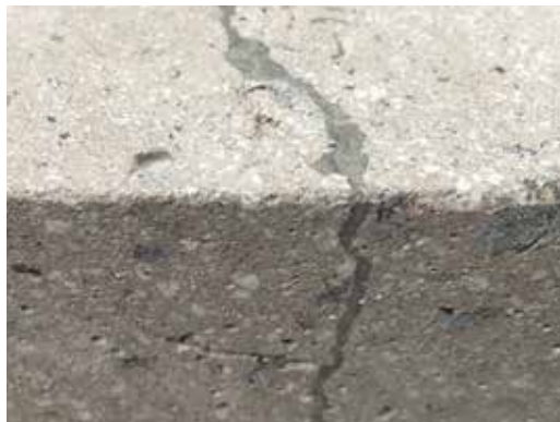
DETALLE DE PENETRACIÓN EN GRIETAS DE GROUTERLEX®
