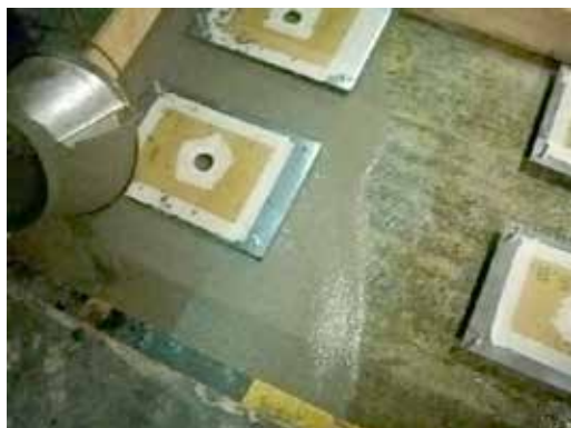
COLADO DE GROUTER E40® BAJO PLACAS
