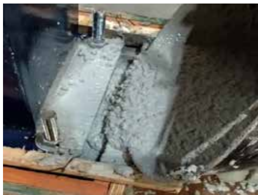
COLADO DE GROUTER E36® BAJO PLACA
