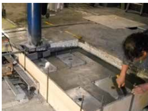
DETALLE DE GROUTING EJECUTADO
