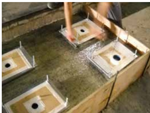
APLICACIÓN DE PUENTE DE ADHERENCIA IMPRIDAMP®
