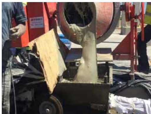
MEZCLADO Y COLADO A BOMBA
