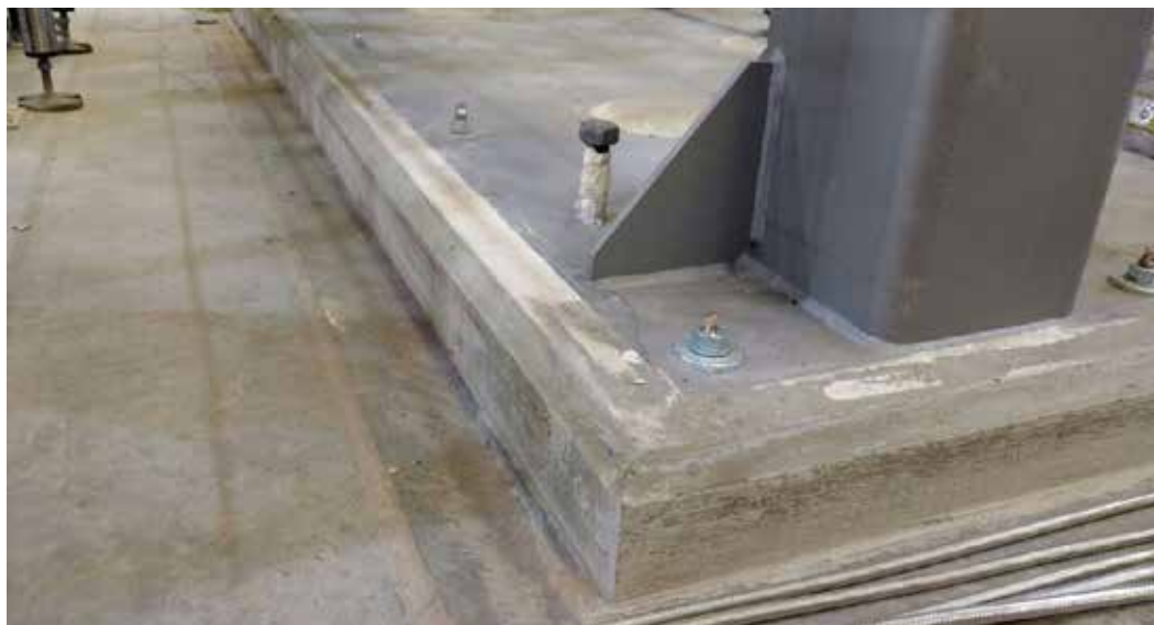
GROUTING EJECUTADO
