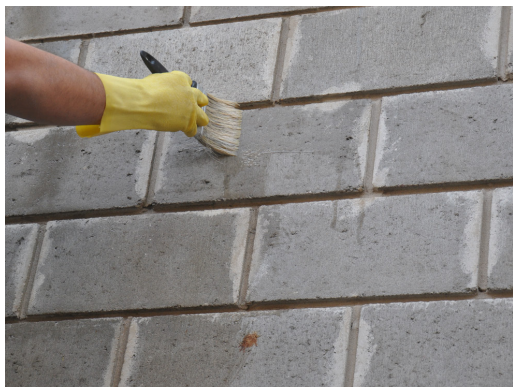
APLICACIÓN DE FERROSIL SH100® CON PINCELETA
