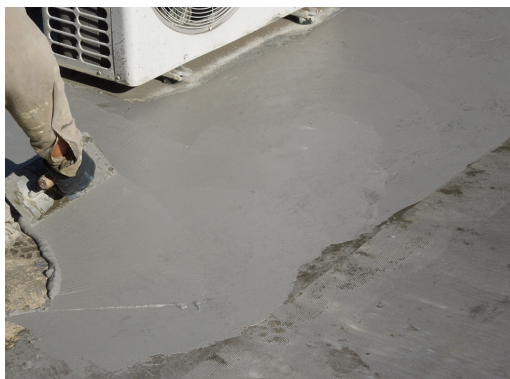
APLICACIÓN DE POLICRET FLEX® + MALLA
