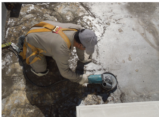
REMOCIÓN DE IMPERMEABILIZACIÓN VIEJA EN TERRAZA
