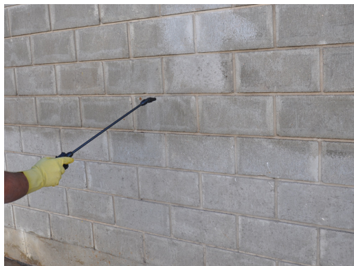
APLICACIÓN DE FERROSIL SH100® CON PULVERIZADOR
