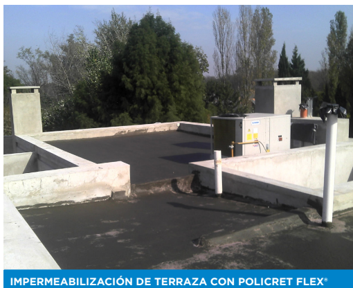
IMPERMEABILIZACIÓN DE TERRAZA CON POLICRET FLEX®
