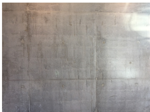
APLICACIÓN SOBRE TABIQUE DE HORMIGÓN VISTO
