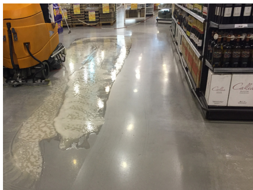
ASPIRADO Y LAVADO DE LA SOLUCIÓN
