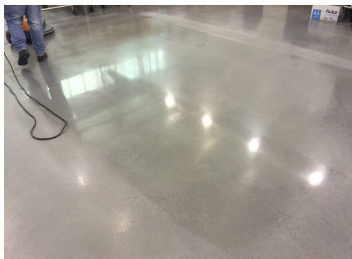
LUSTRADO EN DOS O MÁS DIRECCIONES (1500 RPM)
