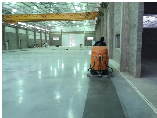
LIMPIEZA CON D500® Y PAD ROJO PIONEER®
