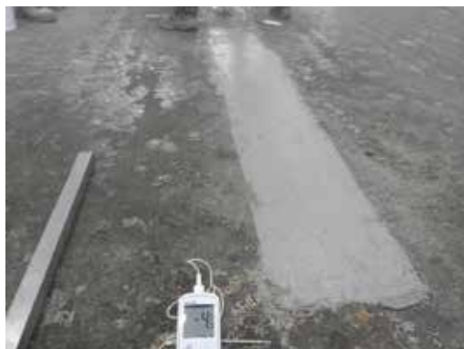
REPARACIÓN CON FERROPUR CR PLUS® A -4,5°C
