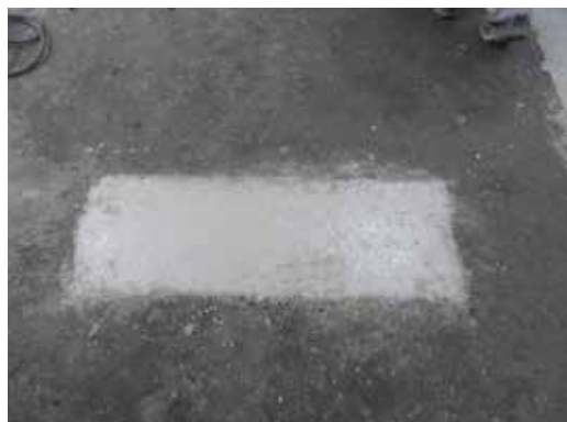
REPARACIÓN FINALIZADA HABILITACIÓN A 4 HS
