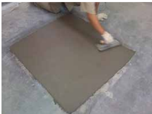
TERMINACIÓN CON LLANA MANUAL
