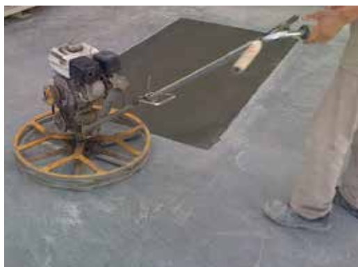
TERMINACIÓN CON LLANA MECÁNICA O MANUAL
