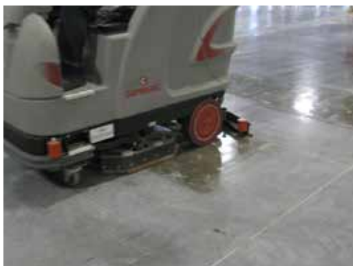
HABILITACIÓN AL TRÁNSITO A 1 HS (>20 MPA)
