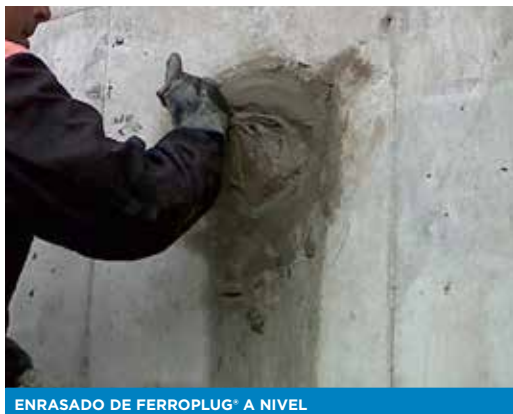
ENRASADO DE FERROPLUG® A NIVEL
