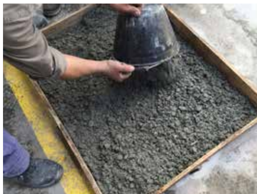
RELLENO CON HORMIGÓN GROUTER U22®
