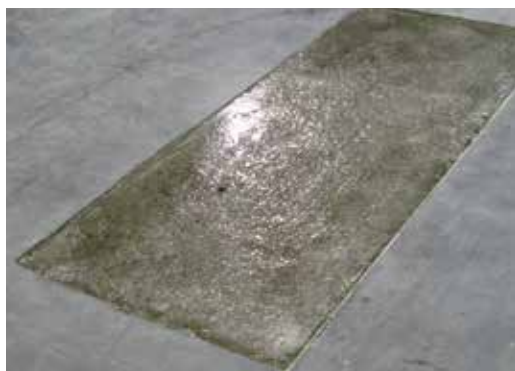
APLICACIÓN DE IMPRIDAMP® PUENTE DE ADHERENCIA
