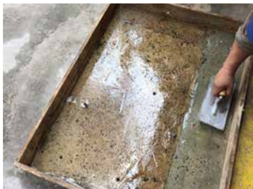
ENCOFRADO E IMPRIMACIÓN CON IMPRIDAMP®
