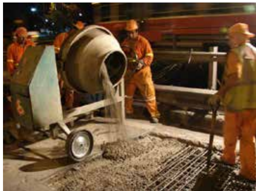
RELLENO CON HORMIGÓN GROUTER AL360®
