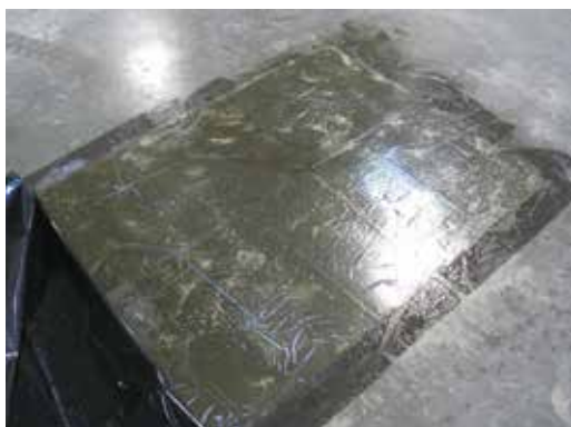
CURADO CON MEMBRANAS MCG® O FERROCURE®
