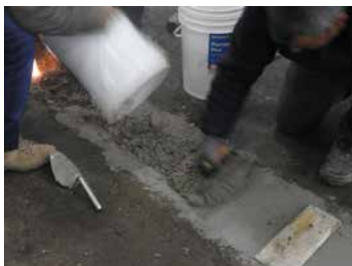
COLADO DEL MORTERO
