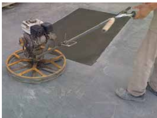
TERMINACIÓN CON LLANA MECÁNICA
