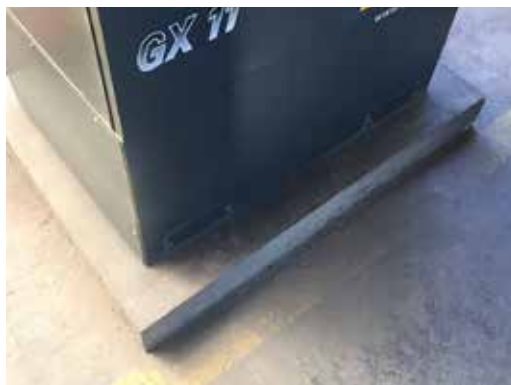
MONTAJE DE COMPRESOR EN MENOS DE 12 HORAS
