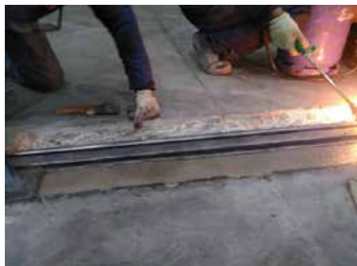
FERROPUR CR PLUS® PARA FIJACIÓN DE GUÍA
