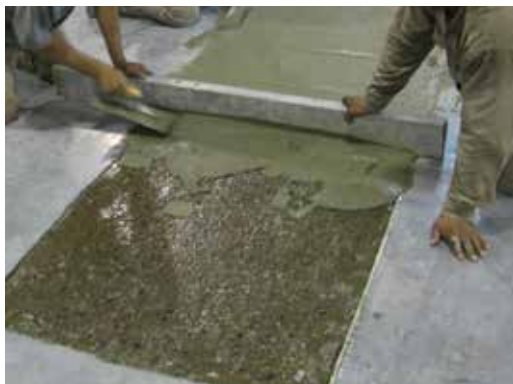
COLADO Y ENRASADO DE GROUTER U22®
