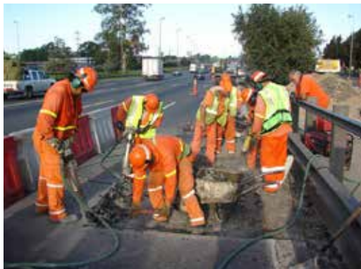
INICIO DE DEMOLICIÓN DE TABLERO DE HORMIGÓN
