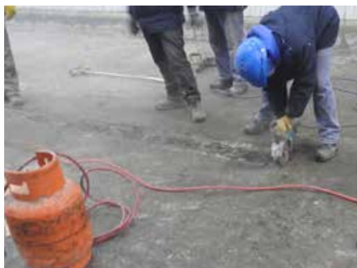
CORTE Y DEMOLICIÓN DEL SECTOR AFECTADO
