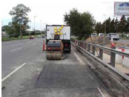
APLICACIÓN DE ASFALTO Y HABILITACIÓN
