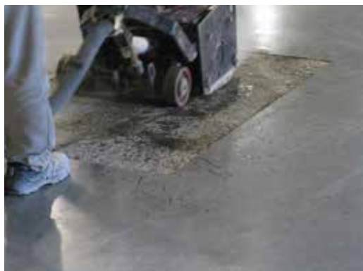
ESCARIFICADO DE LA SUPERFICIE
