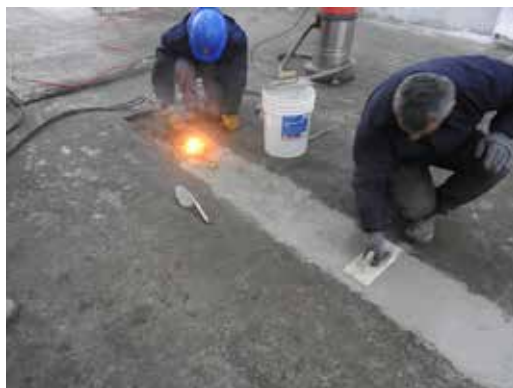
FRATACHADO/LLANEADO DE LA SUPERFICIE
