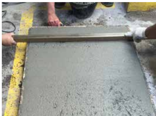
ENRASADO DE HORMIGÓN GROUTER U22®
