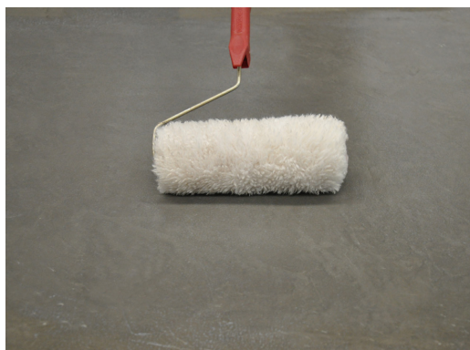
APLICACIÓN DE LACA FERROCRYL SEAL ®
