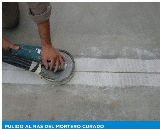
PULIDO AL RAS DEL MORTERO CURADO
