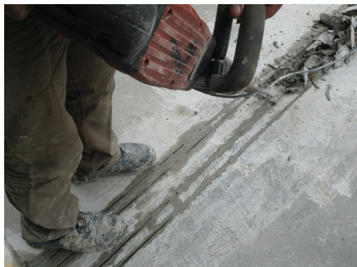
CORTE Y DEMOLICIÓN DE LA JUNTA DETERIORADA
