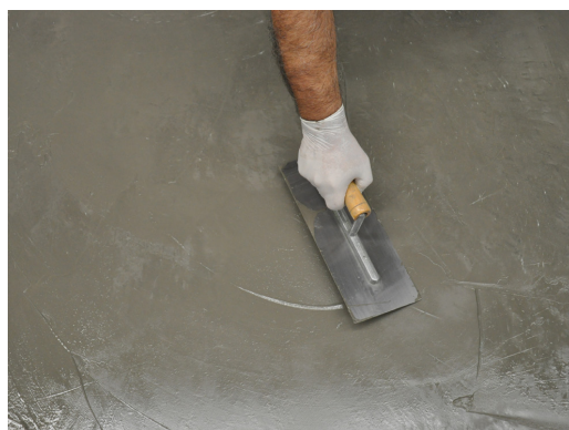
APLICACIÓN DE POLICRET MICRO® CON LLANA
