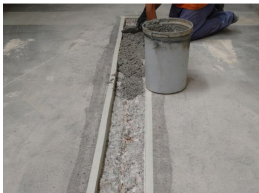
APLICACIÓN FERROPUR CR® CON LLANA
