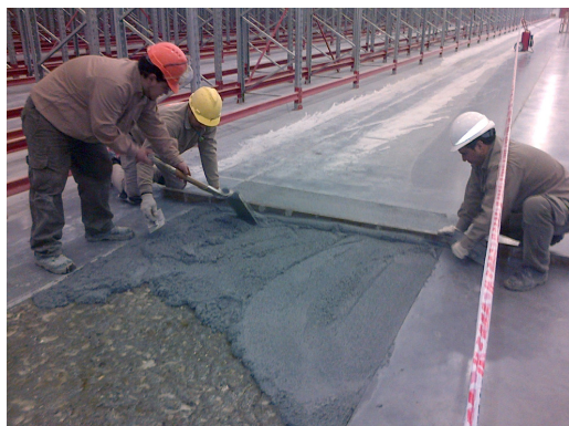
COLADO Y ENRASADO
