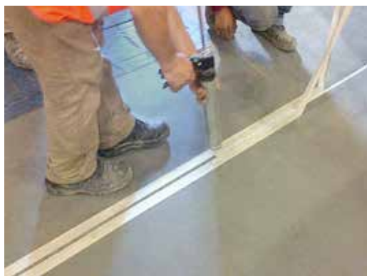
SELLADO DE JUNTA DE CONTROL/CONTRACCIÓN
