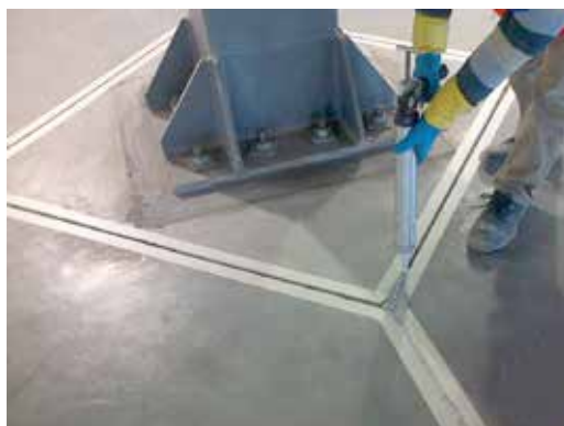
SELLADO DE JUNTA DE DILATACIÓN/MOLDEO
