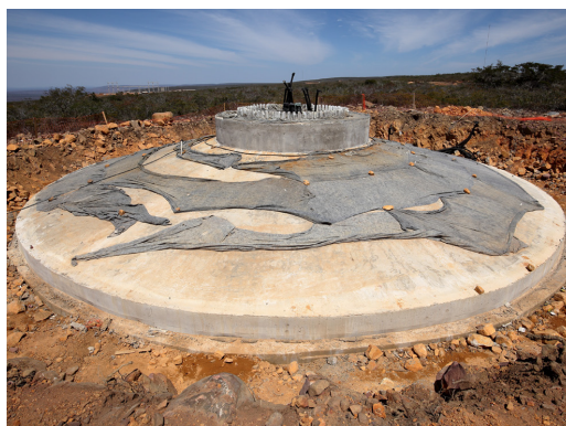
HORMIGÓN COLADO CON EFECTO AUTOCOMPACTANTE
