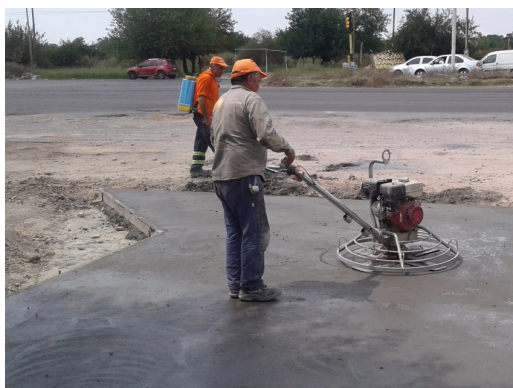
TERMINACIÓN DEL HORMIGÓN EN ACCESO
