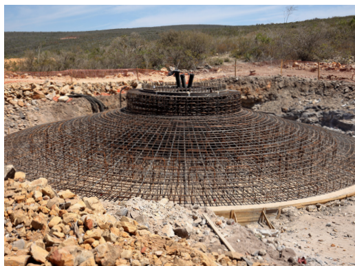
ESTRUCTURA DE HORMIGÓN DENSAMENTE ARMADA
