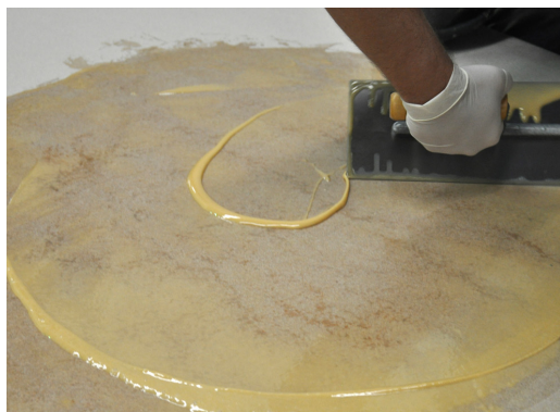
APLICACIÓN DE IMPRIDAMP MB®
