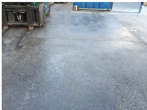
HORMIGÓN MUY POROSO CONSOLIDADO CON RAM C97®
