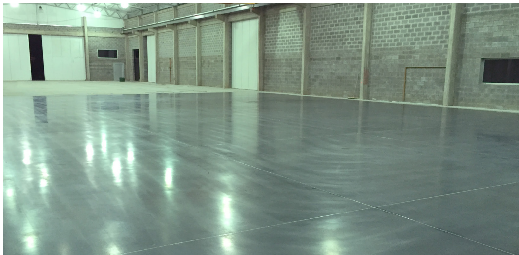
LIMPIEZA FINALIZADA CON D500®
