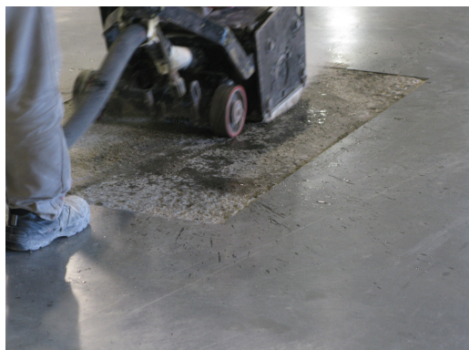
ESCARIFICADO DE LA SUPERFICIE
