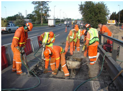
INICIO DE DEMOLICIÓN DE TABLERO DE HORMIGÓN
