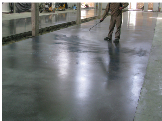
APLICACIÓN DE CURADOR MCG ® O FERROCURE ®
