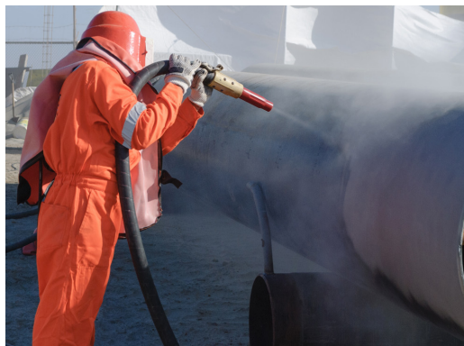
ARENADO/GRANALLADO DE LA SUPERFICIE
