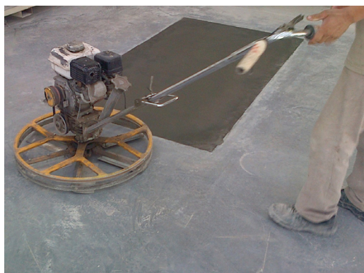
TERMINACIÓN CON LLANA MECÁNICA O MANUAL
