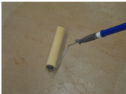
APLICACIÓN DE IMPRIDAMP MB ® CON RODILLO
