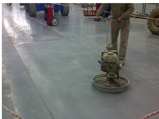
ALISADO CON LLANA MECÁNICA
