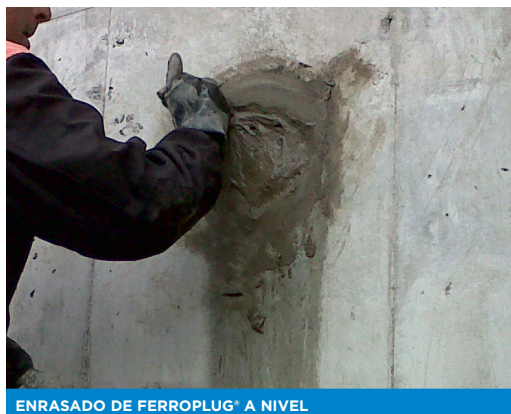
ENRASADO DE FERROPLUG® A NIVEL
