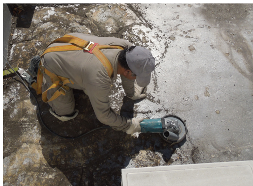
REMOCIÓN DE IMPERMEABILIZACIÓN VIEJA EN TERRAZA
