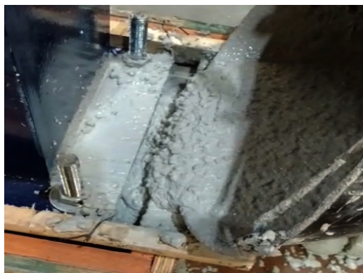
COLADO DE GROUTER E36® BAJO PLACA
