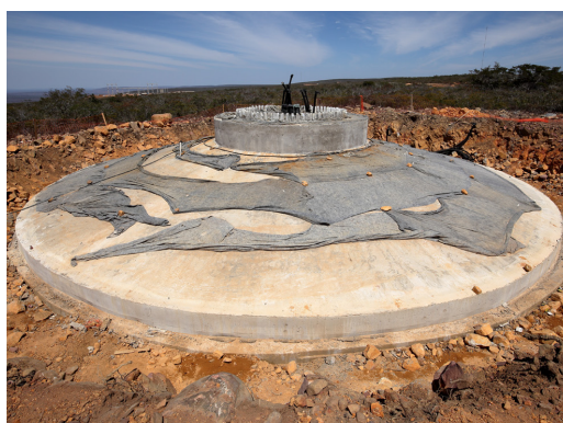
HORMIGÓN COLADO CON EFECTO AUTOCOMPACTANTE
