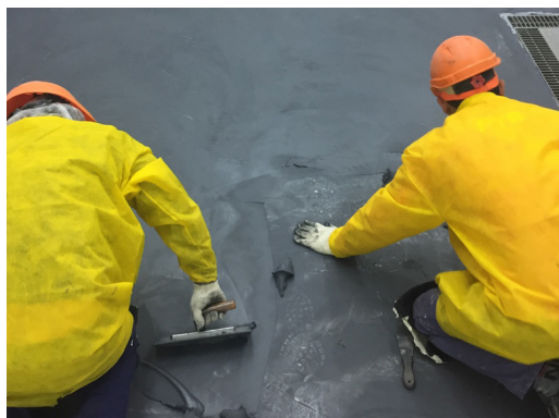
APLICACIÓN DE FERROPUR GMF® CONDUCTIVO
