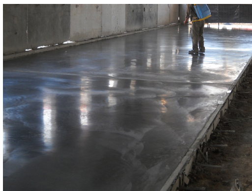
APLICACIÓN DE CURADOR MCG® O FERROCURE®
