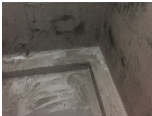
FRAGUADO DE POLICRET WP24® EN TANQUE DE AGUA
