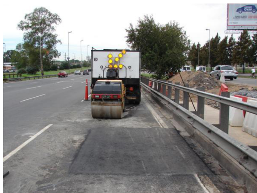
APLICACIÓN DE ASFALTO Y HABILITACIÓN
