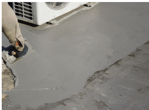
APLICACIÓN DE POLICRET FLEX® + MALLA
