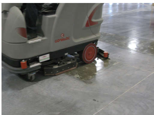
HABILITACIÓN AL TRÁNSITO A 1 HS (>20 MPA)
