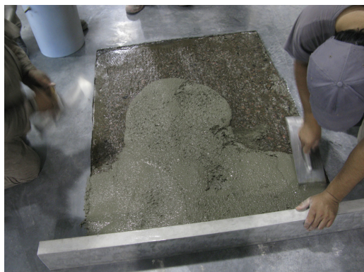
SUPERFICIE HUMEDECIDA, COLADO Y ENRASADO
