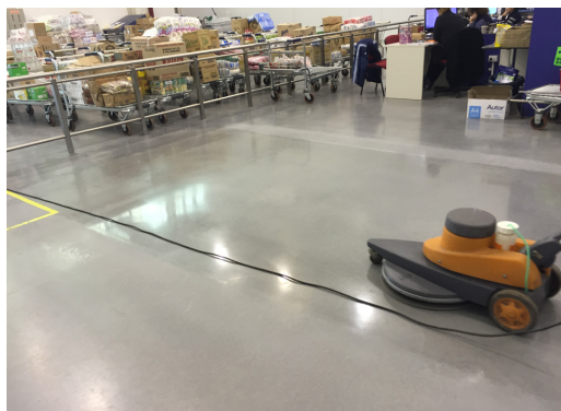
LUSTRADO EN ALTA VELOCIDAD CON PAD PIONEER®
