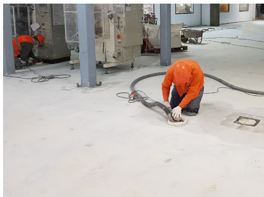
PREPARACIÓN DE LA SUPERFICIE POR PULIDO
