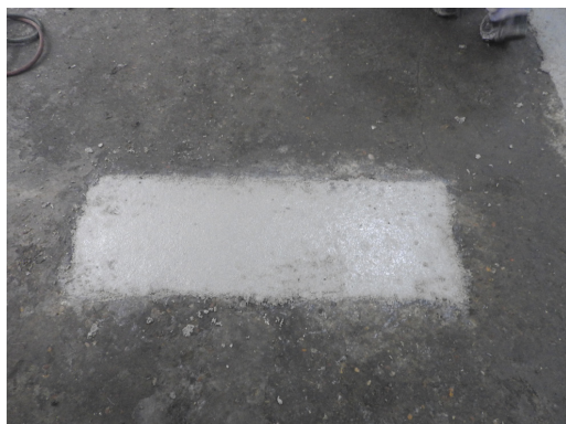
REPARACIÓN FINALIZADA HABILITACIÓN A 4 HS
