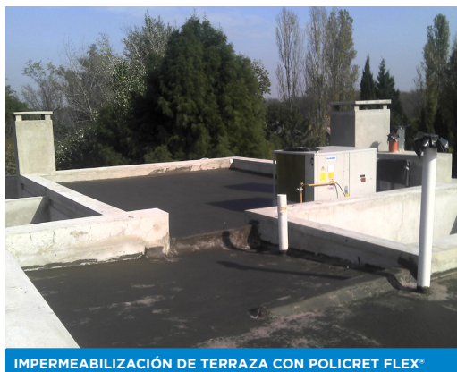
IMPERMEABILIZACIÓN DE TERRAZA CON POLICRET FLEX®
