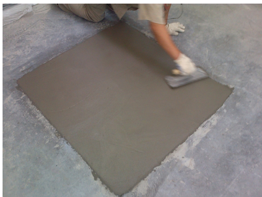
TERMINACIÓN CON LLANA MANUAL
