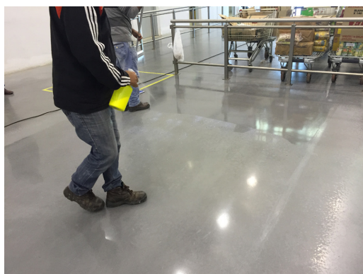
PULVERIZADO DE FERROSIL TOP® (0,04 KG/M²)
