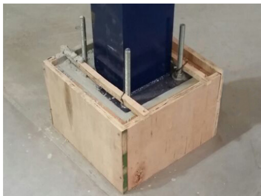
ASENTAMIENTO DEL MORTERO Y CURADO
