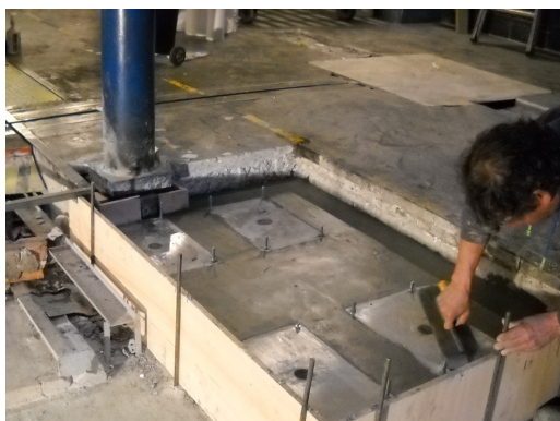
DETALLE DE GROUTING EJECUTADO
