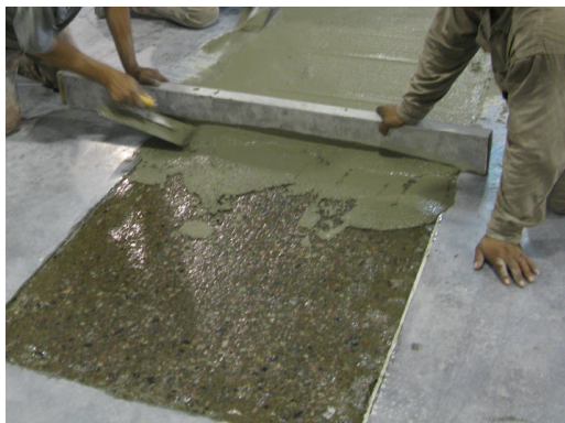
COLADO Y ENRASADO DE GROUTER U22®
