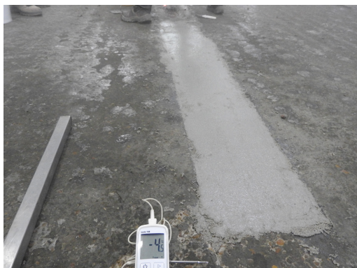
REPARACIÓN CON FERROPUR CR PLUS® A -4,5°C
