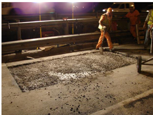
GROUTER AL360® EN 2 HS RESISTENCIA: >25 MPA
