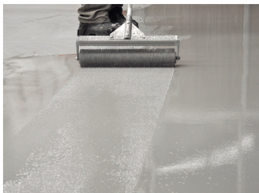
RODILLADO DE FERROPUR MF®
