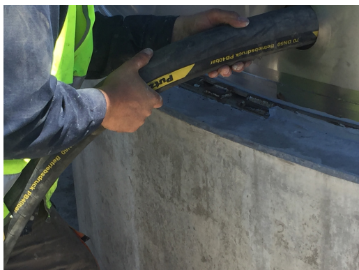
BOMBEO DE LECHADA FLUIDA
