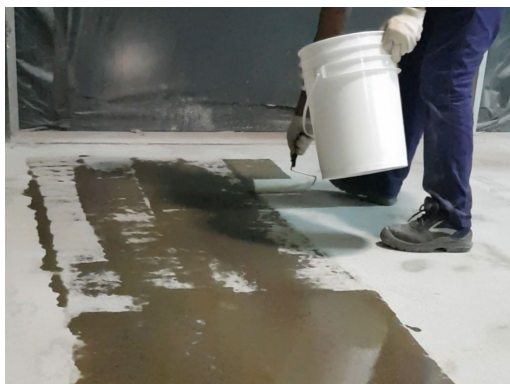
APLICACIÓN RAM C97® CON RODILLO
