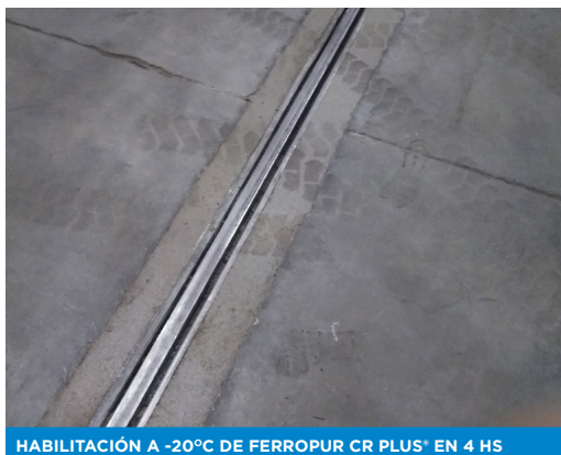
HABILITACIÓN A -20°C DE FERROPUR CR PLUS® EN 4 HS
