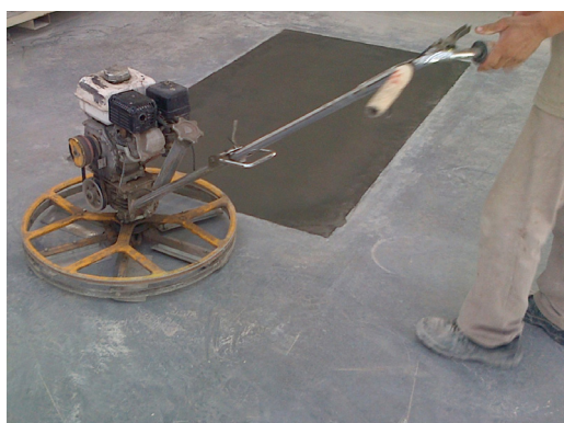
TERMINACIÓN CON LLANA MECÁNICA
