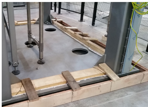
DETALLE DE ENCOFRADO RÍGIDO
