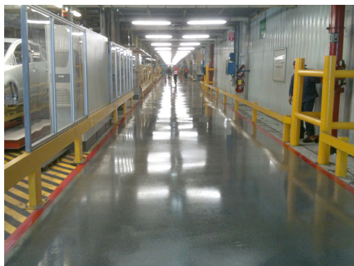
DEJAR SECAR TOTALMENTE ENTRE PELÍCULAS
