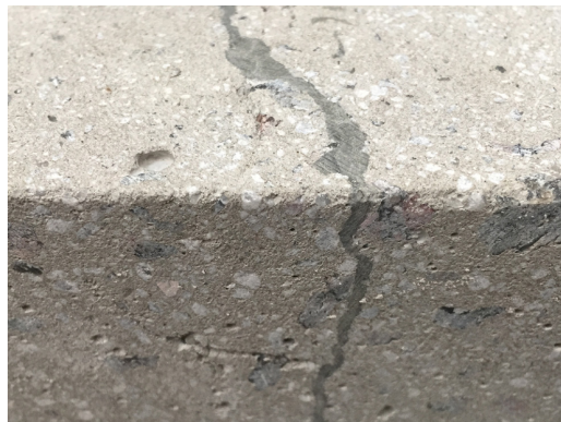
DETALLE DE PENETRACIÓN EN GRIETAS DE GROUTERLEX®
