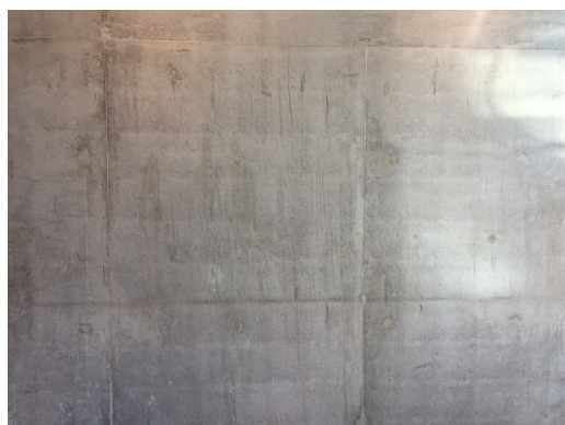
APLICACIÓN SOBRE TABIQUE DE HORMIGÓN VISTO
