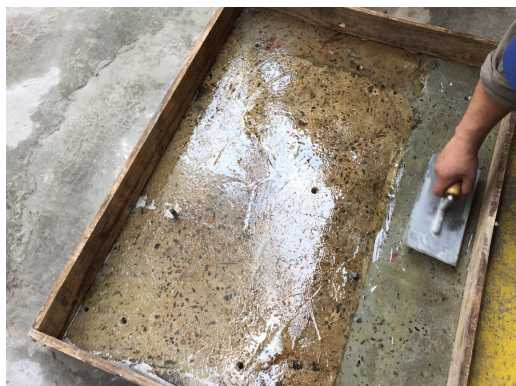
ENCOFRADO E IMPRIMACIÓN CON IMPRIDAMP®
