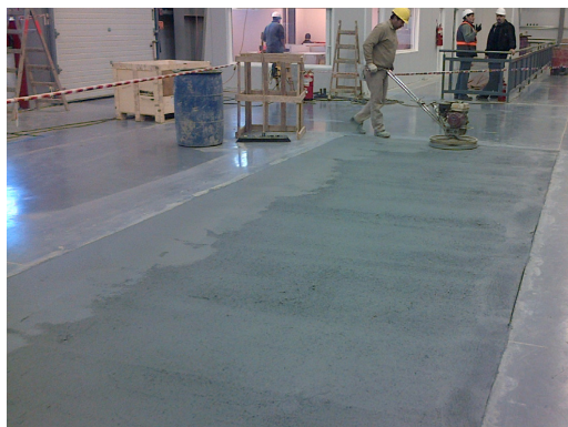
FRATACHADO/PLATO DEL MORTERO
