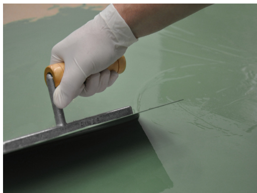
EXTENDIDO DE FERROPUR 400® CON LLANA
