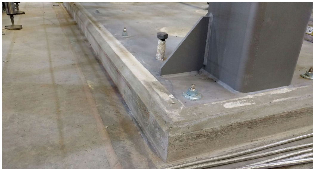
GROUTING EJECUTADO
