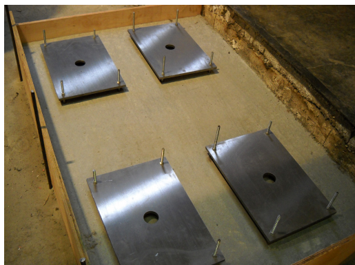
AJUSTE Y NIVELACIÓN DE LAS PLACAS
