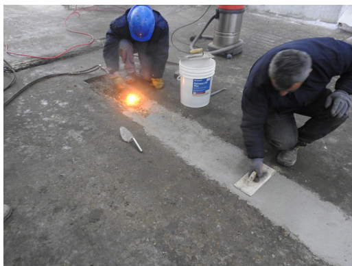
FRATACHADO/LLANEADO DE LA SUPERFICIE
