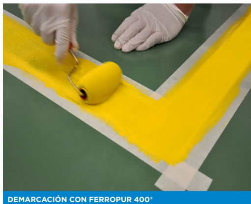
DEMARCACIÓN CON FERROPUR 400®
