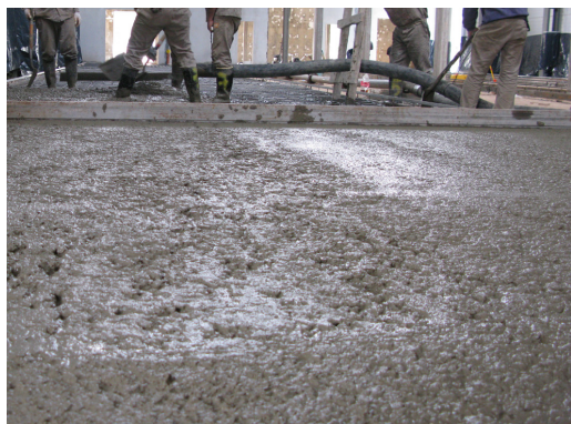
COLADO Y ENRASADO DEL HORMIGÓN
