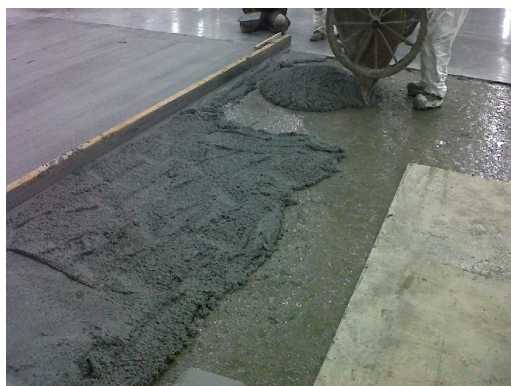
COLADO DE MORTERO CON IMPRIDAMP® FRESCO
