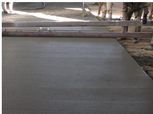
COLADO Y ENRASADO DE GROUTER N28F ®
