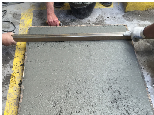
ENRASADO DE HORMIGÓN GROUTER U22®
