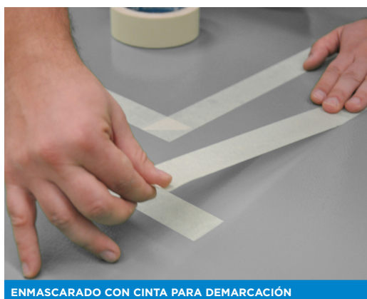
ENMASCARADO CON CINTA PARA DEMARCACIÓN
