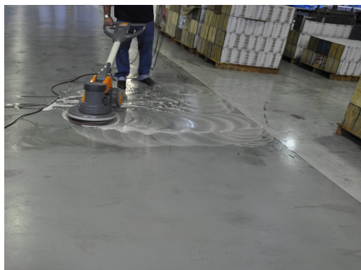
FREGADO CON DILUCIÓN DE AGUA Y D300®
