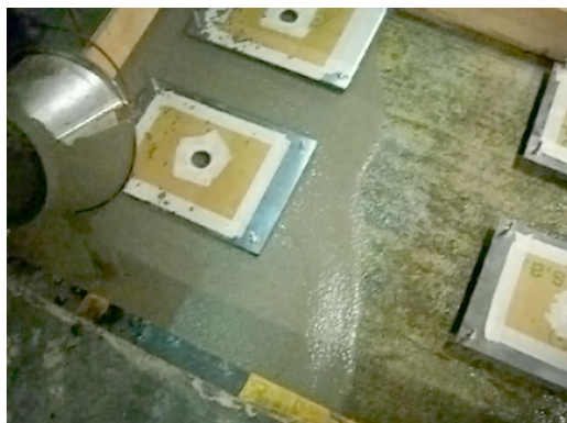
COLADO DE GROUTER E40 ® BAJO PLACAS
