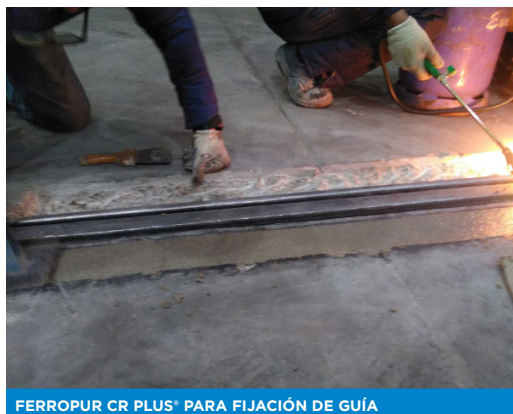
FERROPUR CR PLUS® PARA FIJACIÓN DE GUÍA
