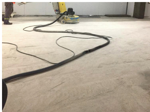
PREPARACIÓN DE LA SUPERFICIE POR PULIDO
