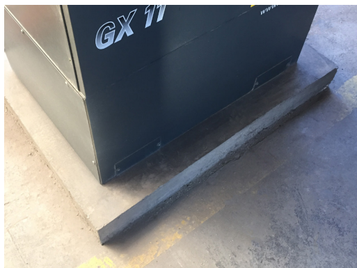
MONTAJE DE COMPRESOR EN MENOS DE 12 HORAS
