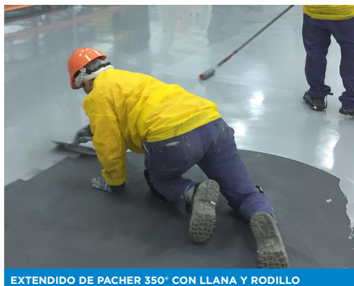
EXTENDIDO DE PACHER 350® CON LLANA Y RODILLO
