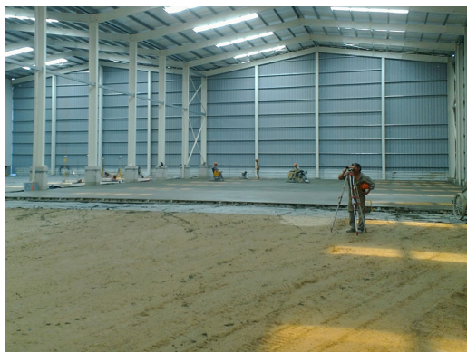
1.000 M² DE HORMIGÓN CON SOLO UNA JUNTA (MOLDEO)
