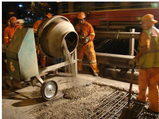
RELLENO CON HORMIGÓN GROUTER AL360®
