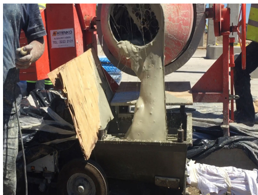
MEZCLADO Y COLADO A BOMBA
