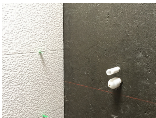
APLICACIÓN DE PORCELANATO SOBRE POLICRET FLEX®
