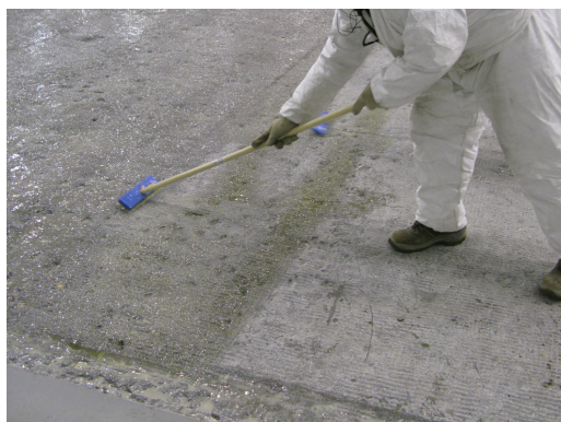
APLICACIÓN DE IMPRIDAMP® CON CEPILLO
