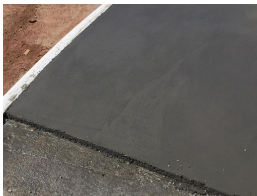
ENRASADO Y ALISADO DEL MORTERO
