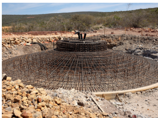
ESTRUCTURA DE HORMIGÓN DENSAMENTE ARMADA
