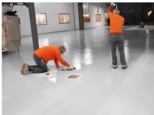
SEGUNDA MANO EXTENDIDA CON LLANA Y RODILLO
