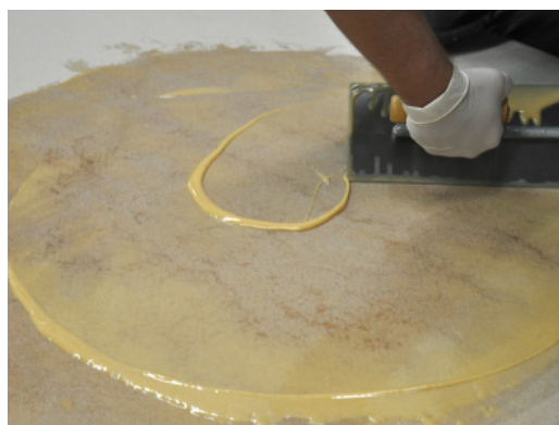
APLICACIÓN DE IMPRIDAMP MB® CON LLANA
