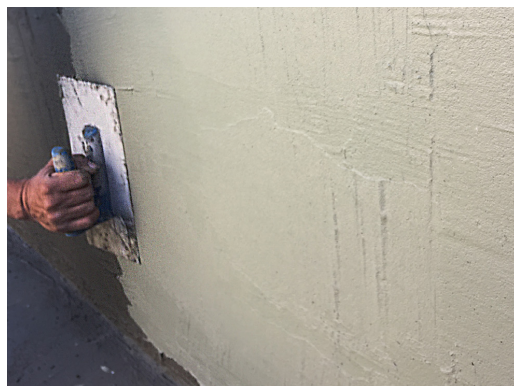
APLICACIÓN DE POLICRET FLEX® CON LLANA
