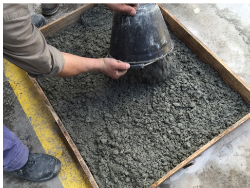
RELLENO CON HORMIGÓN GROUTER U22®
