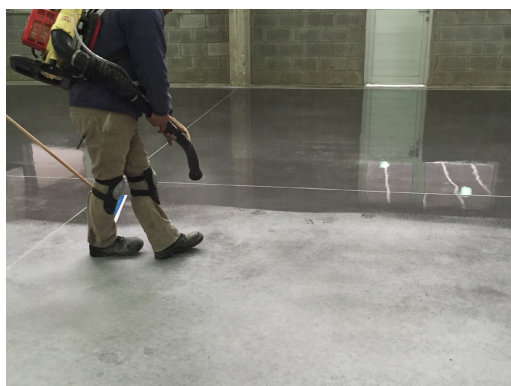
PULVERIZADO/ROCIADO DE FERROSIL LITIO®
