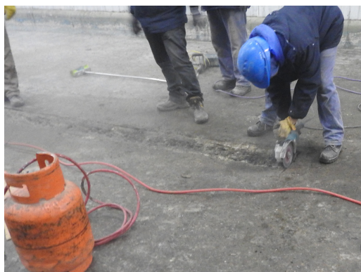
CORTE Y DEMOLICIÓN DEL SECTOR AFECTADO
