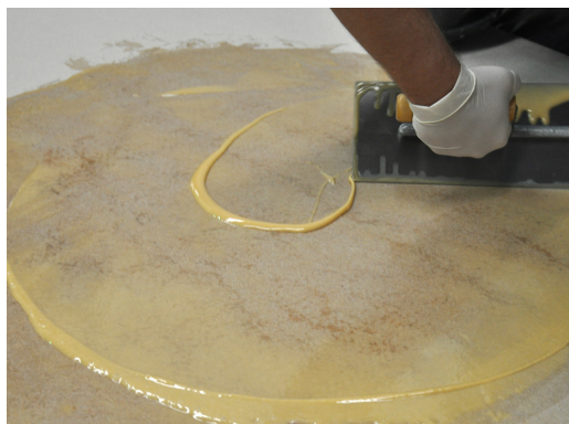
APLICACIÓN DE IMPRIDAMP MB ® CON LLANA
