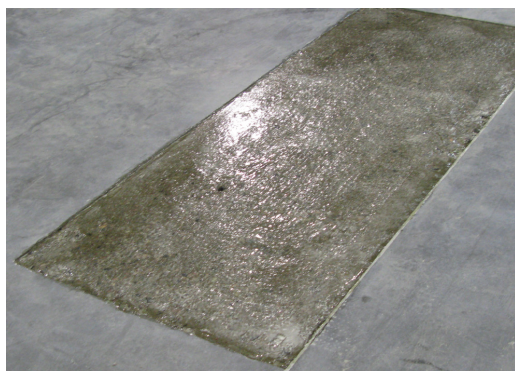
APLICACIÓN DE IMPRIDAMP® PUENTE DE ADHERENCIA
