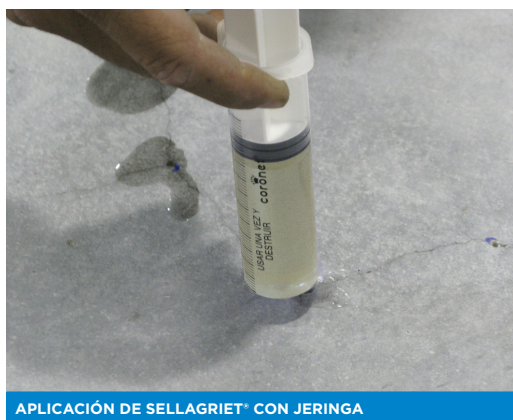
APLICACIÓN DE SELLAGRIET® CON JERINGA
