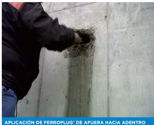
APLICACIÓN DE FERROPLUG® DE AFUERA HACIA ADENTRO
