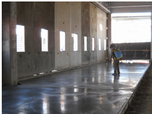
PULVERIZADO DE CURADOR MCG®
