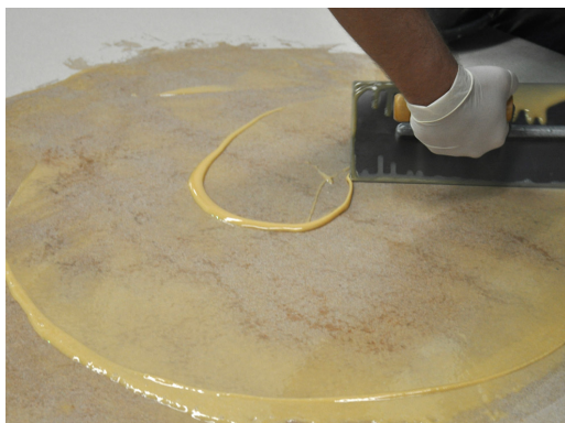
APLICACIÓN DE IMPRIDAMP MB® CON LLANA
