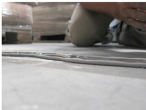
DETALLE DE CONTENCIÓN PARA REPOSO DE LA RESINA
