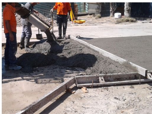
HORMIGÓN DE RÁPIDA HABILITACIÓN EN ACCESO
