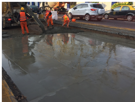
COLADO DE RDC
