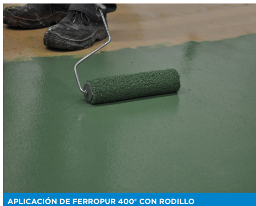
APLICACIÓN DE FERROPUR 400® CON RODILLO
