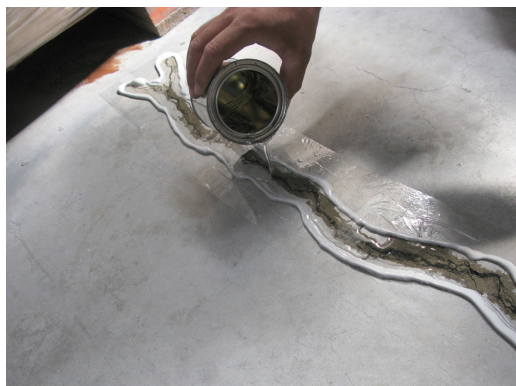
COLADO DIRECTO DE SELLAGRIET® EN UNA GRIETA
