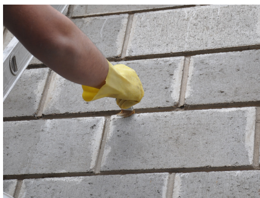
REFUERZO DE APLICACIÓN CON PINCEL EN EL MORTERO
