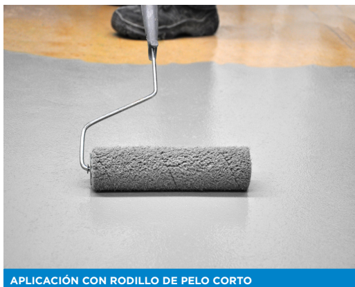
APLICACIÓN CON RODILLO DE PELO CORTO
