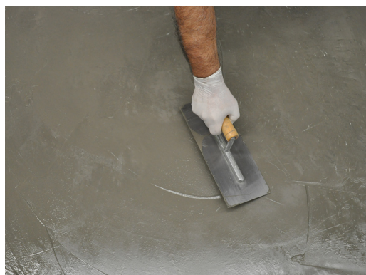
APLICACIÓN DE POLICRET MICRO® CON LLANA
