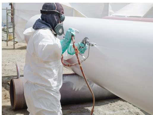
APLICACIÓN DE FERROPUR 401® CON AIRLESS
