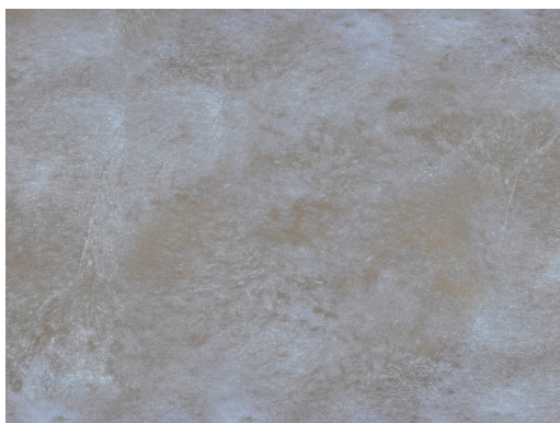
CUBRIR A SATURACIÓN EL HORMIGÓN
