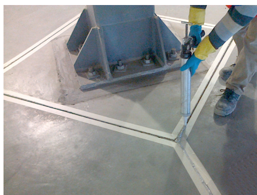
SELLADO DE JUNTA DE DILATACIÓN/MOLDEO
