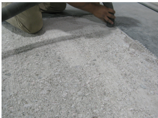
LIMPIEZA Y ASPIRACIÓN DE POLVILLO
