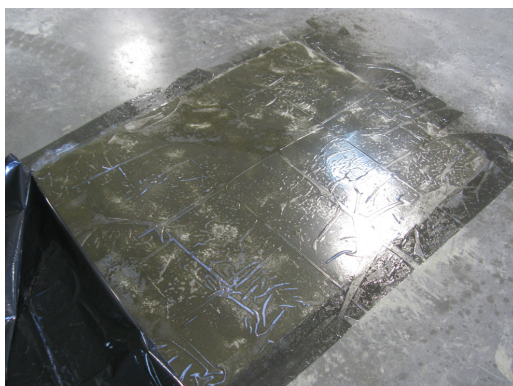
CURADO CON MEMBRANAS MCG® O FERROCURE®
