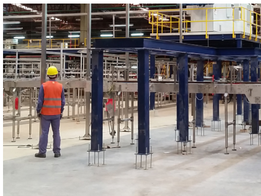
AJUSTE Y NIVELACIÓN DE COLUMNAS
