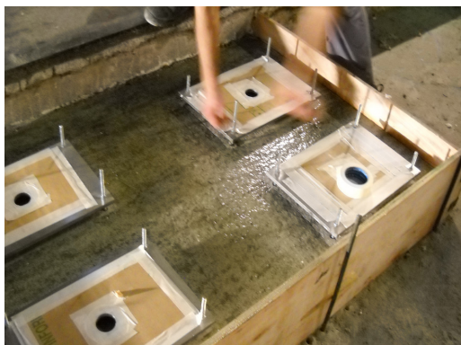
APLICACIÓN DE PUENTE DE ADHERENCIA IMPRIDAMP ®
