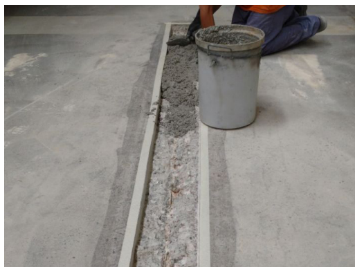
APLICACIÓN FERROPUR CR® CON LLANA
