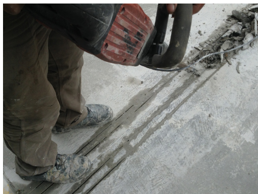
CORTE Y DEMOLICIÓN DE LA JUNTA DETERIORADA
