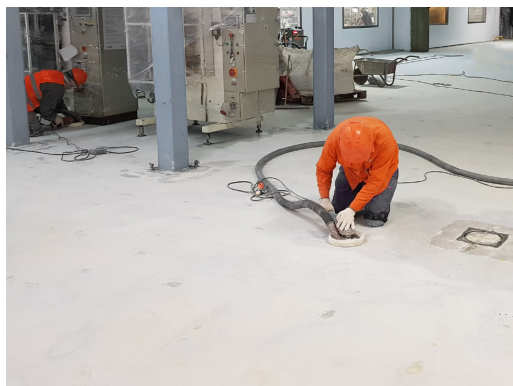
PREPARACIÓN DE LA SUPERFICIE POR PULIDO
