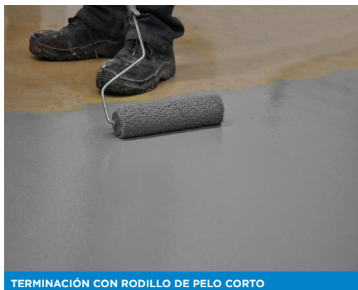
TERMINACIÓN CON RODILLO DE PELO CORTO
