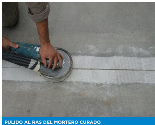
PULIDO AL RAS DEL MORTERO CURADO
