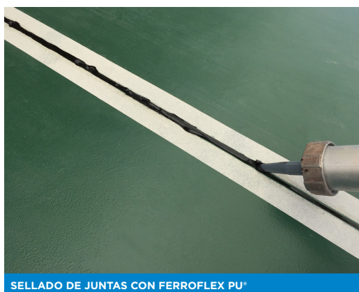
SELLADO DE JUNTAS CON FERROFLEX PU®
