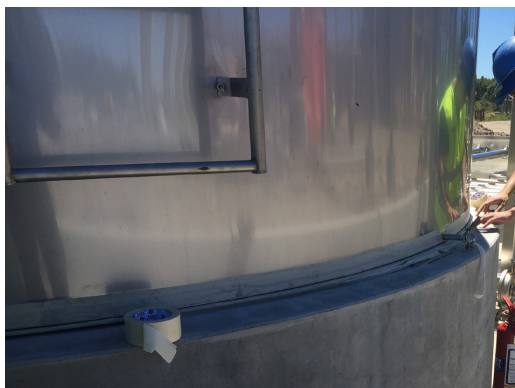
SELLADO PERIMETRAL PARA COLADO DE GROUTERLEX®
