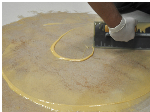
APLICACIÓN DE IMPRIDAMP MB® CON LLANA
