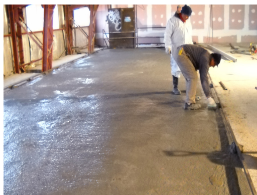
MASILLA PUENTE DE ADHERENCIA APLICADA
