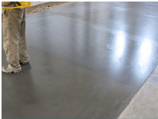
CURADOR MCG® EXTENDIDO CON RODILLO
