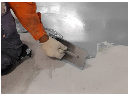
PRIMER MANO DE FERROPUR GMF® COMO ENDUIDO
