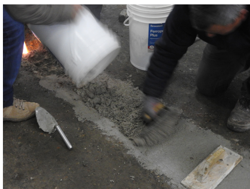
COLADO DEL MORTERO
