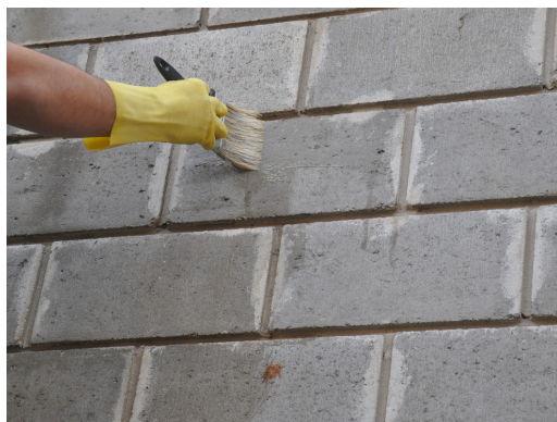
APLICACIÓN DE FERROSIL SH100® CON PINCELETA
