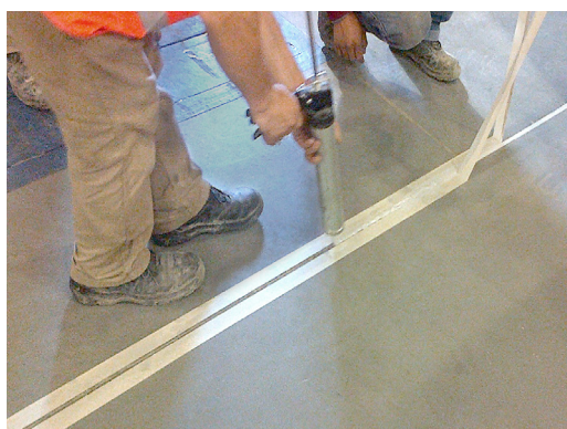
SELLADO DE JUNTA DE CONTROL/CONTRACCIÓN
