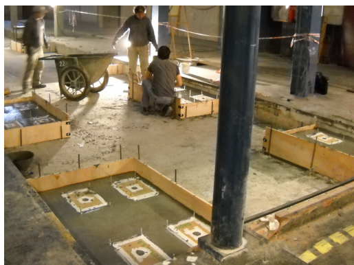
DETALLE DE GROUTING EN BASES DE PRECISIÓN
