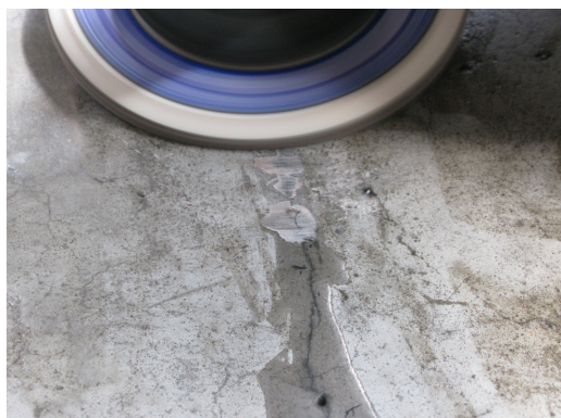
ELIMINACIÓN DEL EXCEDENTE CON LIJA - DISCO FLEXIBLE
