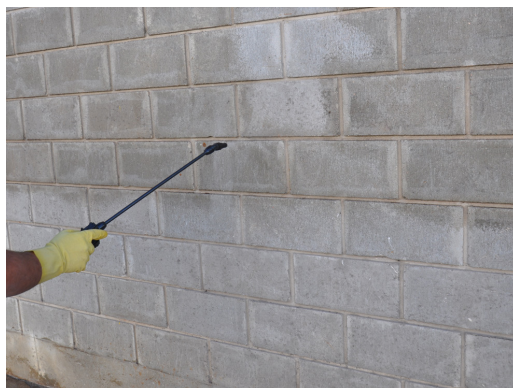
APLICACIÓN DE FERROSIL SH100® CON PULVERIZADOR
