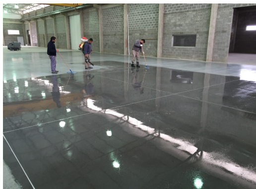
EXTENDIDO DE FERROSIL LITIO® CON MOPA PLANA
