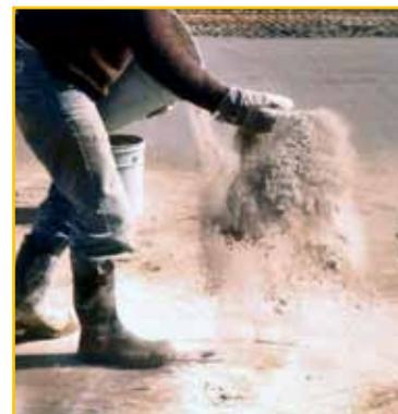
El Krystol Broadcast produce un acabado liso en el piso y es utilizado para impermeabilizar integralmente e incrementar la durabilidad en losas de concreto, que serán allanadas mecánicamente durante el acabado:
