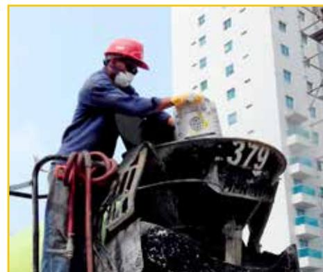
KIM es usado para impermeabilizar integralmente e incrementar la durabilidad de todo concreto sujeto a la exposición de agua y presión hidrostática:
