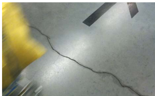
Tratamiento de fisuras: Sellegriet® & Grouterlex®
