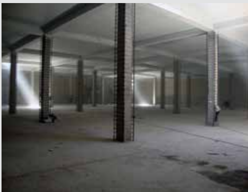
Trabajos de reparación en tanque Belenes Guadalajara, México
