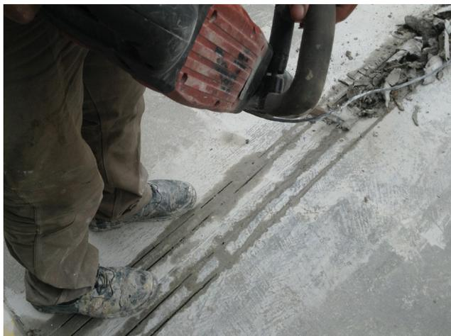
CORTE Y DEMOLICIÓN DE LA JUNTA DETERIORADA
