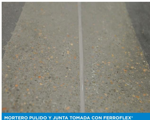
MORTERO PULIDO Y JUNTA TOMADA CON FERROFLEX®
