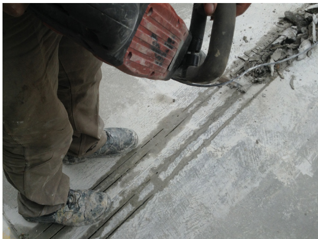
CORTE Y DEMOLICIÓN DE LA JUNTA DETERIORADA
