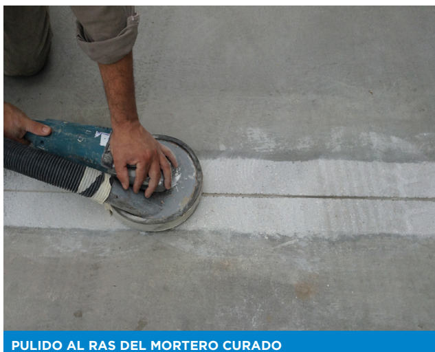
PULIDO AL RAS DEL MORTERO CURADO
