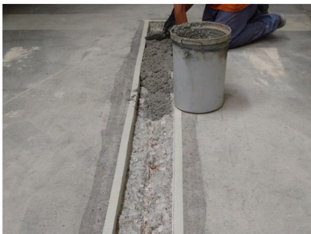
APLICACIÓN FERROPUR CR® CON LLANA
