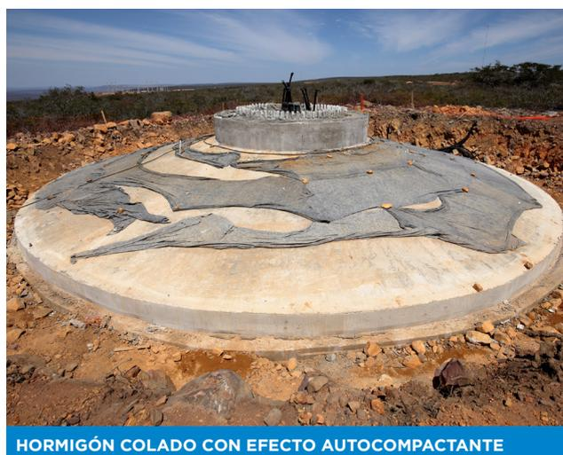
HORMIGÓN COLADO CON EFECTO AUTOCOMPACTANTE
