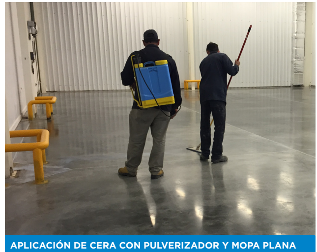
APLICACIÓN DE CERA CON PULVERIZADOR Y MOPA PLANA
