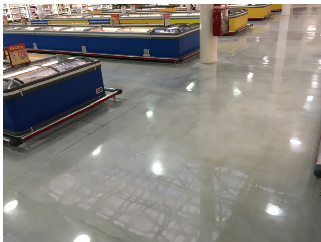
PISO DE HORMIGÓN CON FERROSIL TOP®
