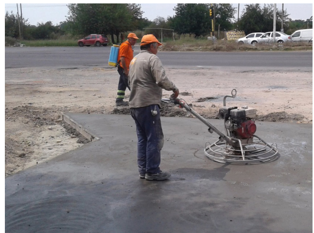
TERMINACIÓN DEL HORMIGÓN EN ACCESO
