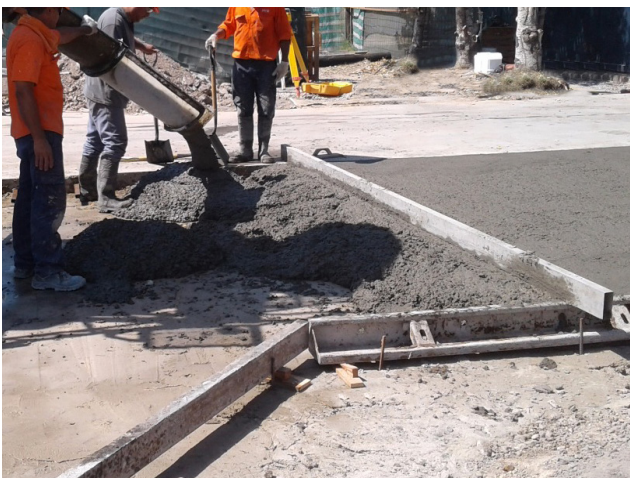
HORMIGÓN DE RÁPIDA HABILITACIÓN EN ACCESO
