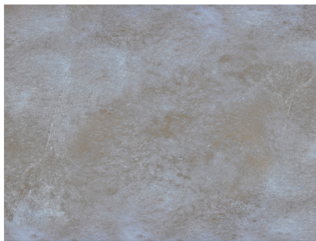
CUBRIR A SATURACIÓN EL HORMIGÓN
