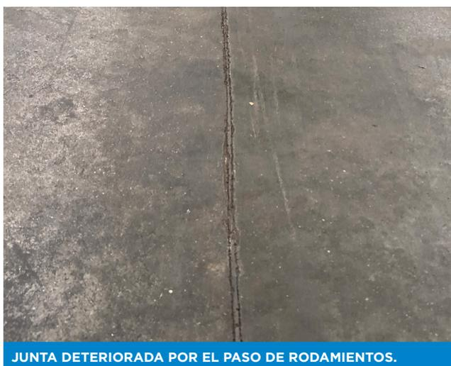
JUNTA DETERIORADA POR EL PASO DE RODAMIENTOS.
