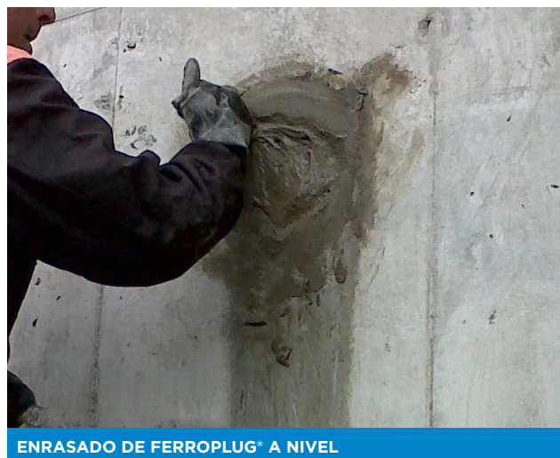
APLICACIÓN DE FERROPLUG® DE AFUERA HACIA ADENTRO
