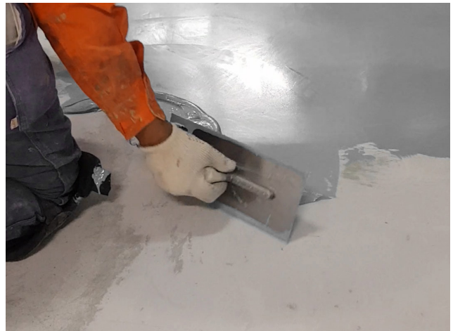
PRIMER MANO DE FERROPUR GMF® COMO ENDUIDO
