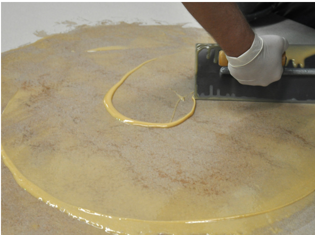
APLICACIÓN DE IMPRIDAMP MB®
