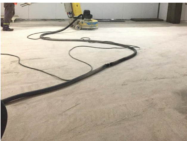
PREPARACIÓN DE LA SUPERFICIE POR PULIDO
