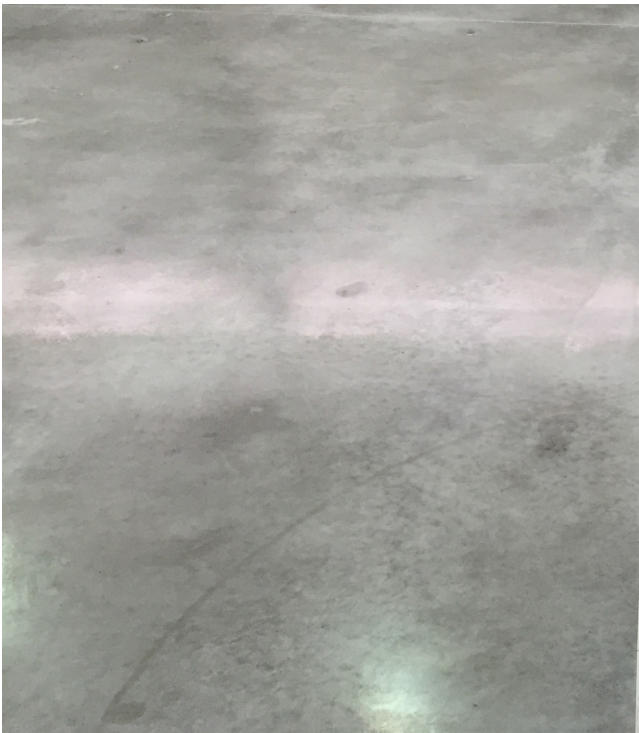
PISO CON FERROSIL LITIO®
