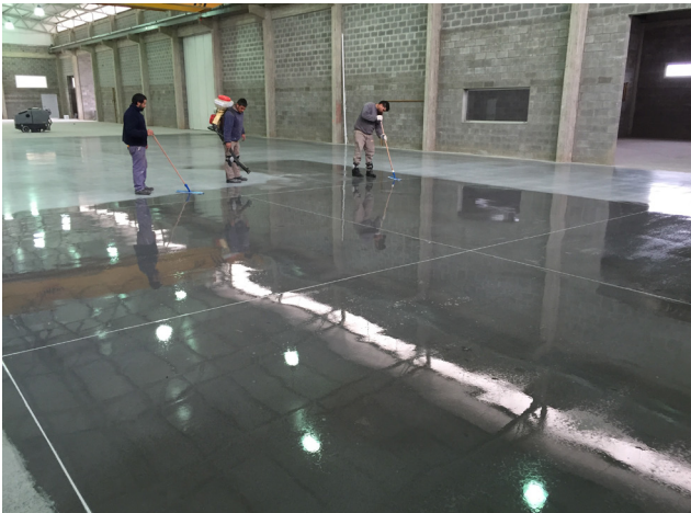
EXTENDIDO DE FERROSIL LITIO® CON MOPA PLANA
