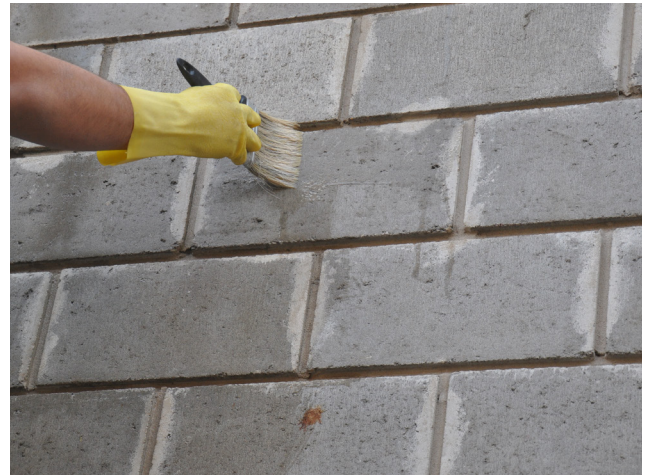
APLICACIÓN DE FERROSIL SH100® CON PINCELETA
