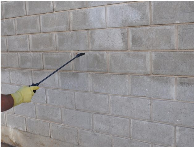
APLICACIÓN DE FERROSIL SH100® CON PULVERIZADOR
