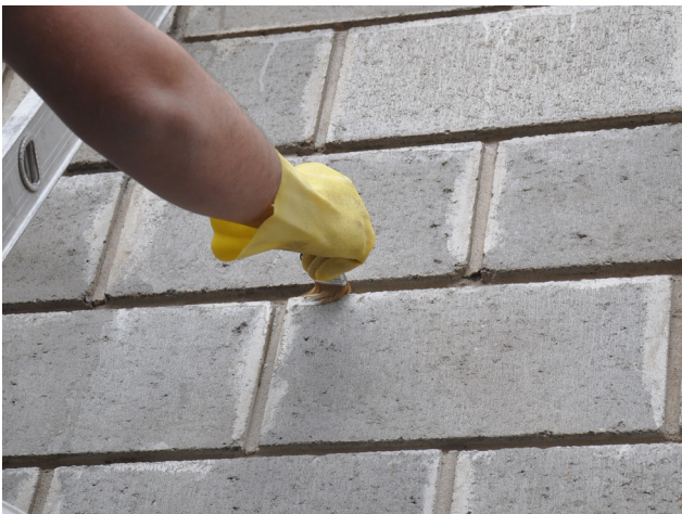
REFUERZO DE APLICACIÓN CON PINCEL EN EL MORTERO
