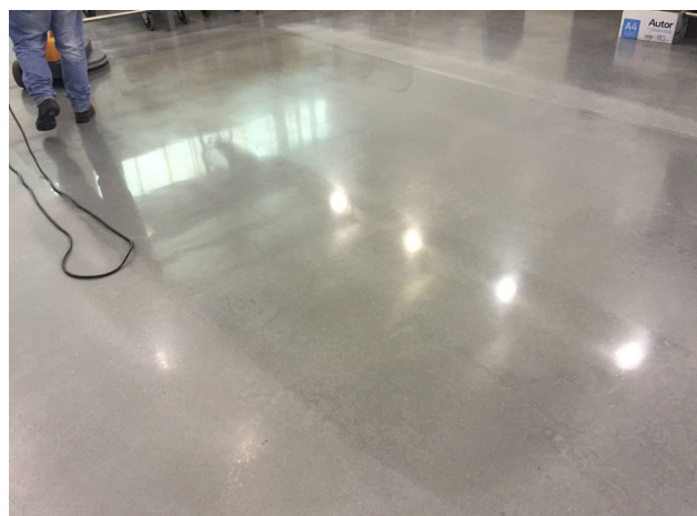
LUSTRADO EN DOS O MÁS DIRECCIONES (1500 RPM)
