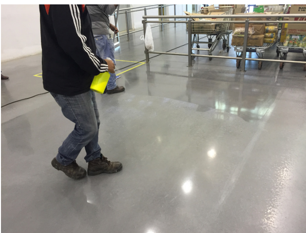
PULVERIZADO DE FERROSIL TOP® (0,04 KG/M 2 )
