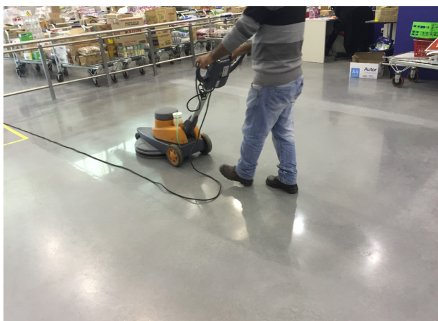
LUSTRADO EN ALTA VELOCIDAD CON PAD PIONEER®
