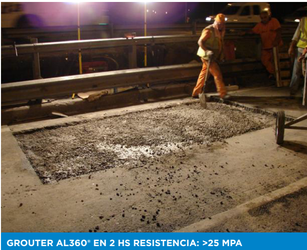
INICIO DE DEMOLICIÓN DE TABLERO DE HORMIGÓN
