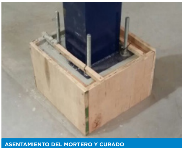
AJUSTE Y NIVELACIÓN DE COLUMNAS
