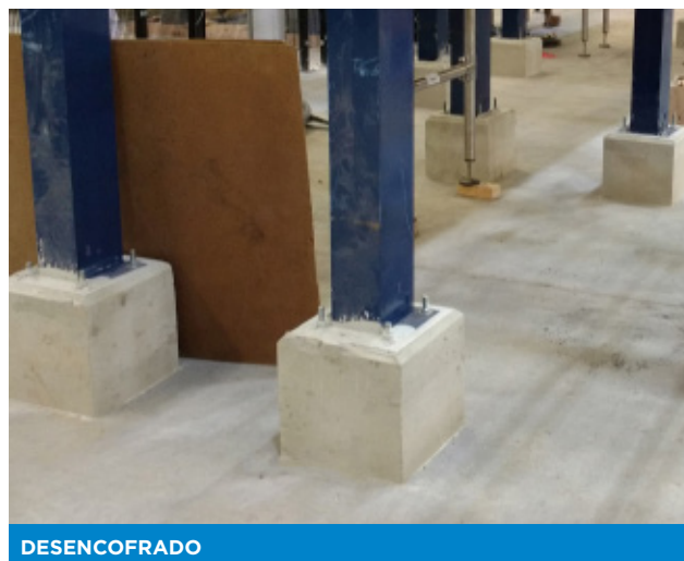
COLADO DE GROUTER E36® BAJO PLACA
