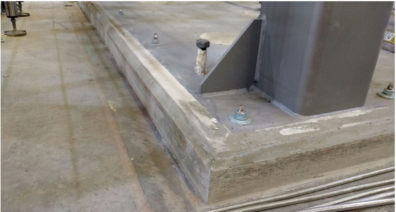
GROUTING EJECUTADO
