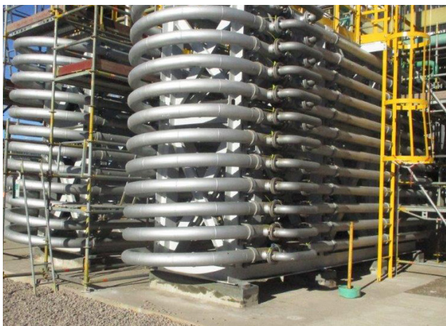
GROUTER EPOXI® EN BASES DE APOYO
