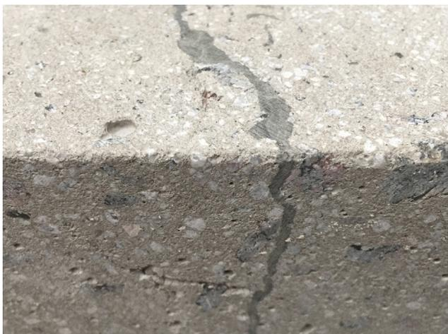
DETALLE DE PENETRACIÓN EN GRIETAS DE GROUTERLEX®
