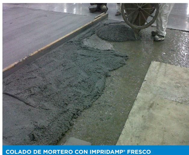
COLADO DE MORTERO CON IMPRIDAMP® FRESCO
