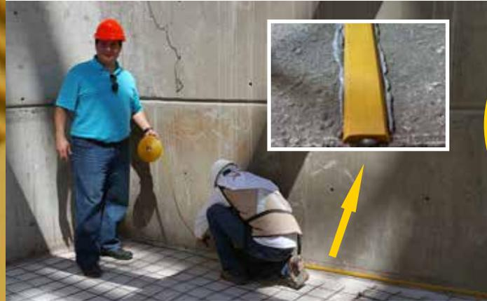
La Banda Hidroexpansiva Krytonite es fácil de instalar y es ideal para una amplia variedad de juntas constructivas y penetraciones de tuberías.
