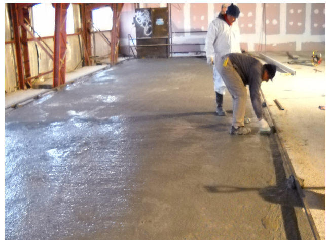
MASILLA PUENTE DE ADHERENCIA APLICADA
