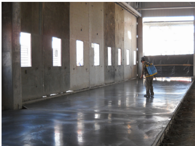
PULVERIZADO DE CURADOR MCG®
