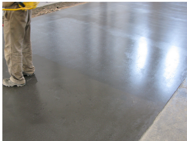
CURADOR MCG® EXTENDIDO CON RODILLO
