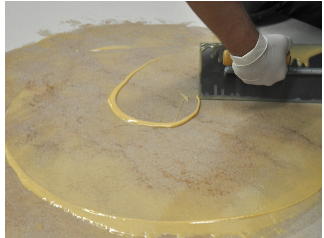
APLICACIÓN DE IMPRIDAMP MB® CON LLANA
