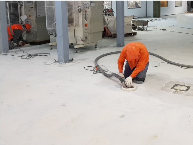
PREPARACIÓN DE LA SUPERFICIE POR PULIDO
