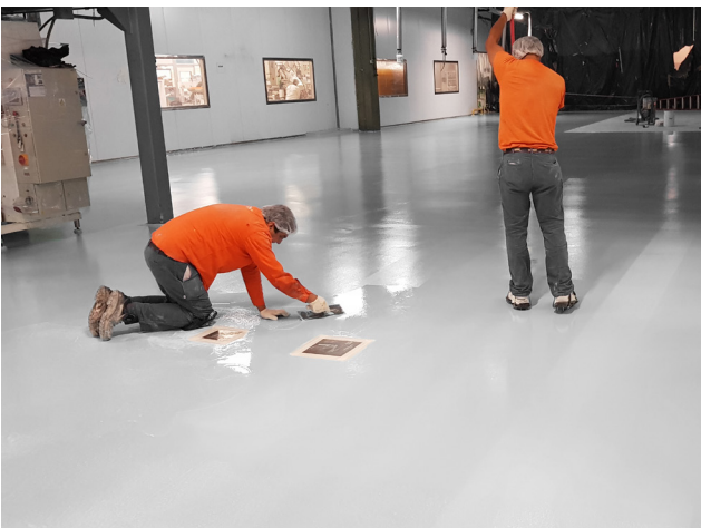
SEGUNDA MANO EXTENDIDA CON LLANA Y RODILLO
