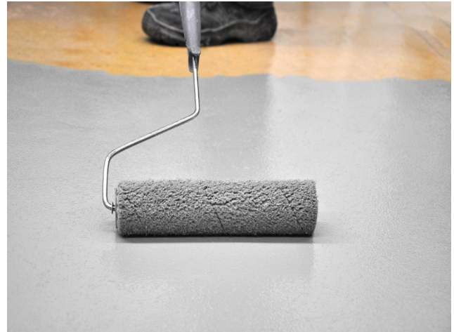
APLICACIÓN CON RODILLO DE PELO CORTO
