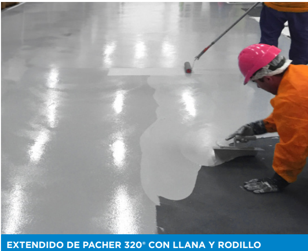
EXTENDIDO DE PACHER 320® CON LLANA Y RODILLO
