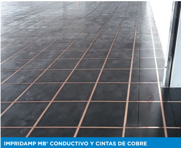
IMPRIDAMP MB® CONDUCTIVO Y CINTAS DE COBRE
