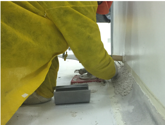
APLICACIÓN DE MORTERO EN ZÓCALO
