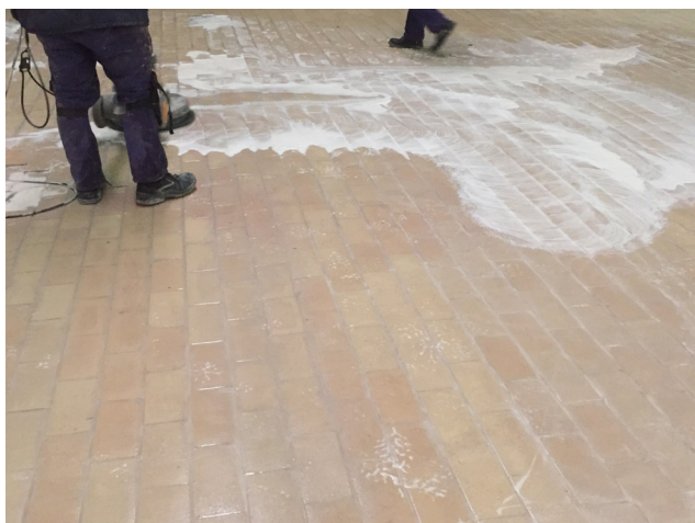
LIMPIEZA DEL EXCEDENTE CON FREGADORA Y PAD
