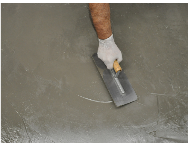
APLICACIÓN DE POLICRET MICRO® CON LLANA
