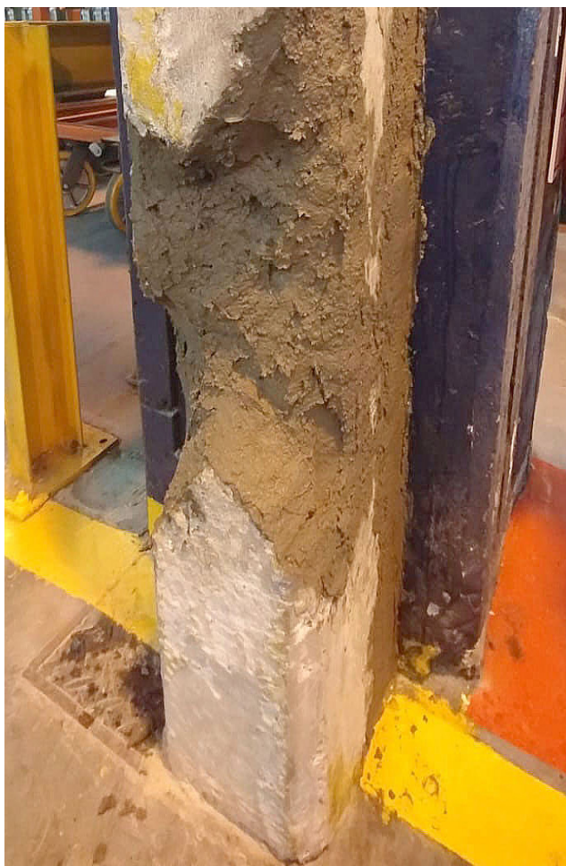
APLICACIÓN DE POLICRET MR® POR CAPAS
