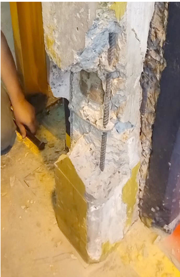
DEMOLICIÓN DE HORMIGÓN SUELTO
