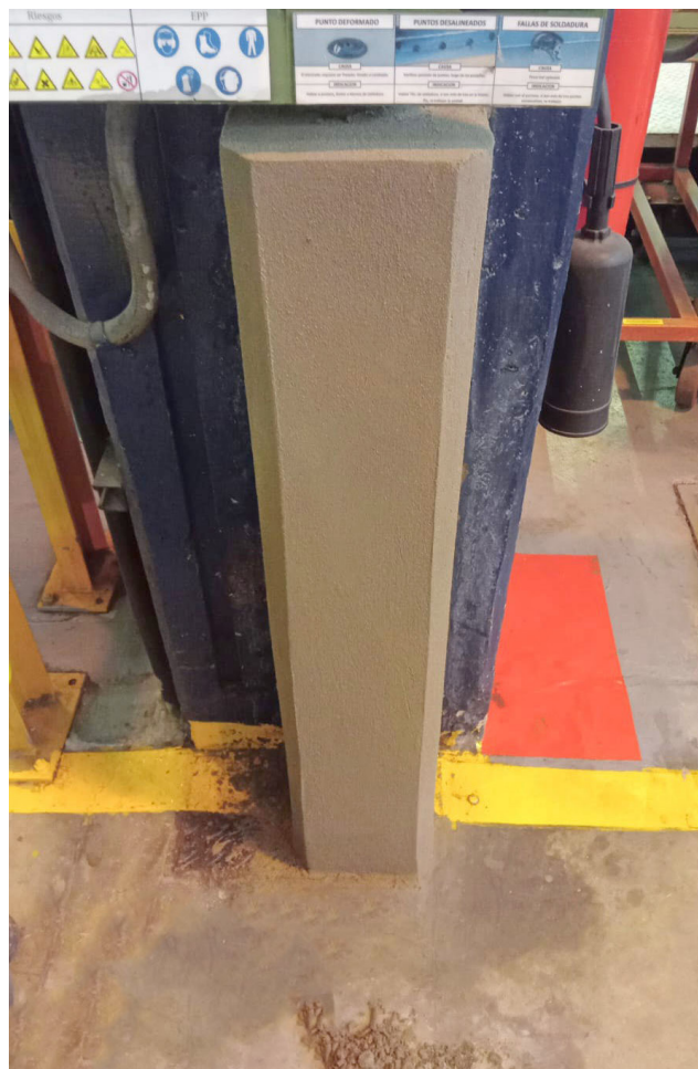
ENRASADO Y ALISADO DEL MORTERO
