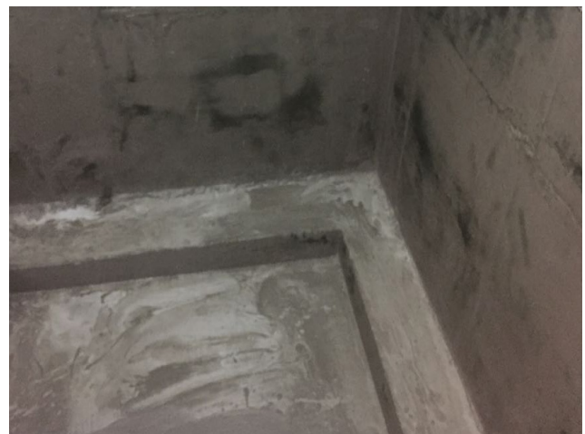
FRAGUADO DE POLICRET WP24® EN TANQUE DE AGUA
