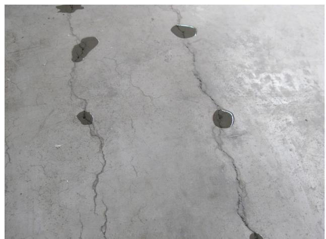
INYECTAR RESINA HASTA SATURACIÓN
