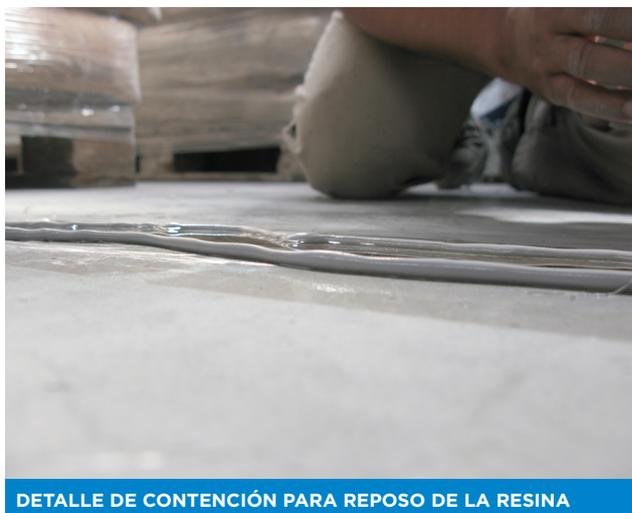
DETALLE DE CONTENCIÓN PARA REPOSO DE LA RESINA
